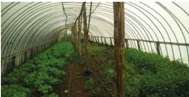
Foto 10. Invernadero tradicional semicircular con estructura de madera
