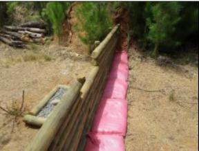
Diques con disipador de rocas y sacos para disipar la energía de la escorrentía. 2020.
