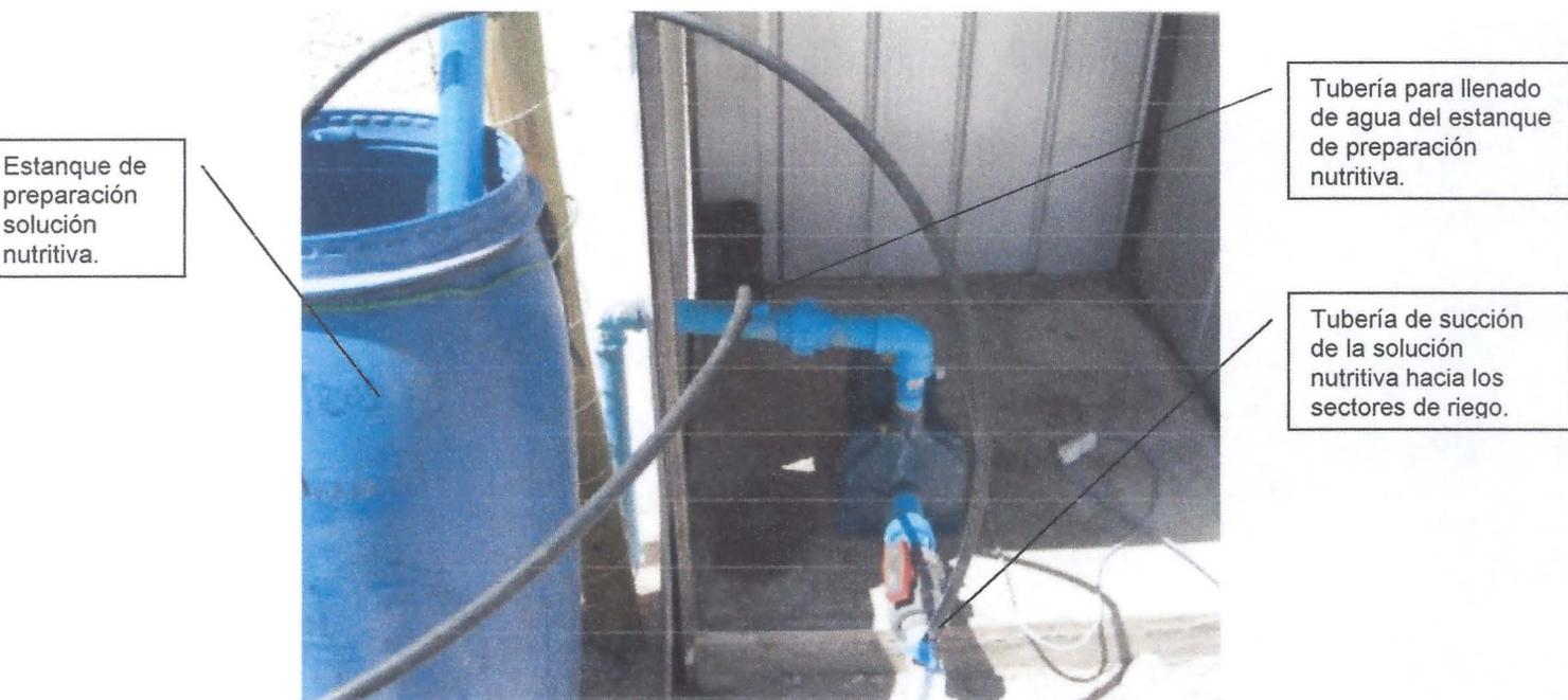
Figura 11. Estanque inyección solución nutritiva.
