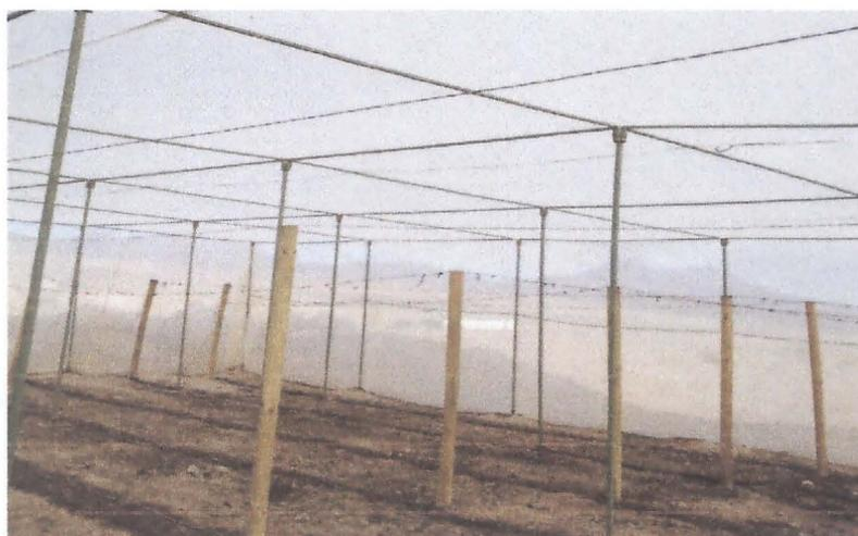
Figura 14. Parte interna del invernadero con estructura para el colgado de tomate.
