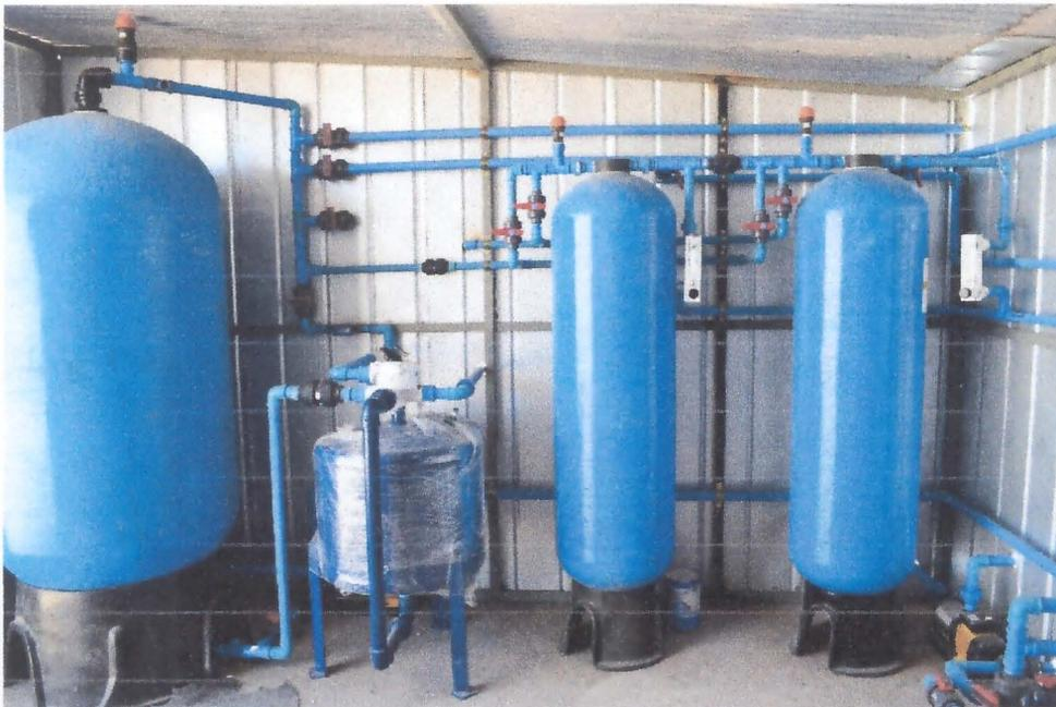
Figura 32. De Izquierda a Derecha: Columna para remoción de boro, Filtro de cuarzo previo al ingreso a las columnas de tratamiento (columnas para remoción de Arsénico).
