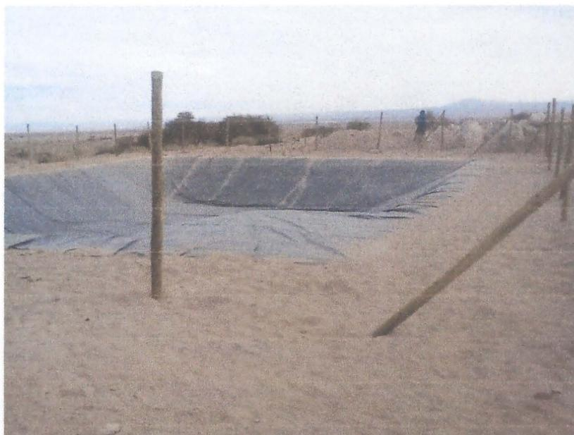
Figura 38. Estanque de acumulación de agua tratada con su cobertura de HDPE (Liner) y cierre perimetral.
