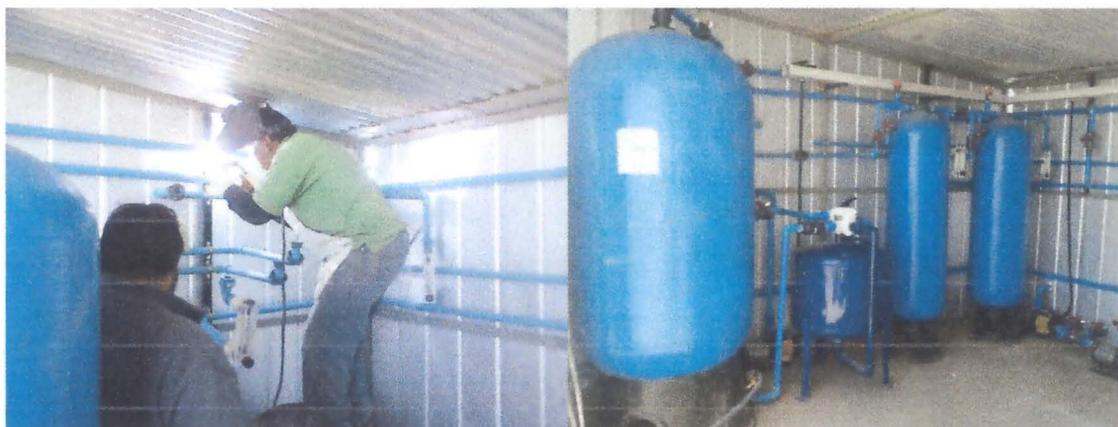
Figura 4. Construcción y montaje planta de tratamiento.
