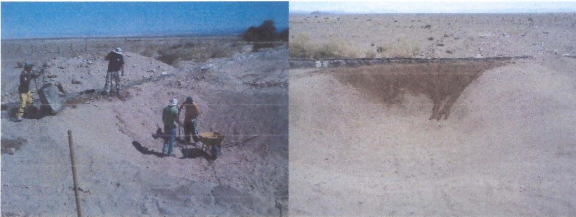
Figura 40. Faena de afinamiento del pozo de bombeo (Izquierda). Afinamiento del pozo de bombeo terminado (Derecha).
