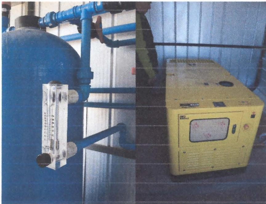
Figura 34. Rotámetros para equalización de flujo entre columnas específicas para Arsénico (Izquierda). Grupo Electrónico (Derecha).
