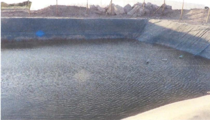
Figura 6. Estanque de almacenamiento agua tratada producida por la planta de tratamiento de agua.
