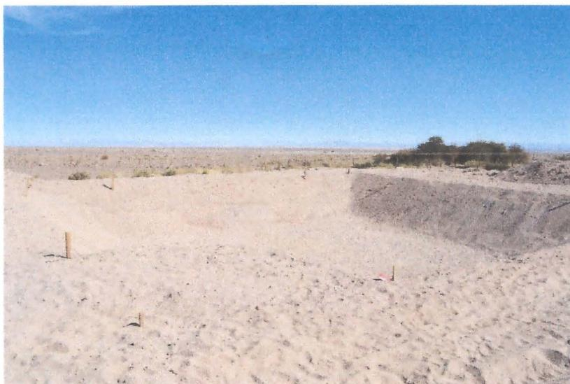
Figura 37. Estanque de acumulación de agua tratada una vez excavado y afinado previo a la colocación del recubrimiento de HDPE (Liner).
