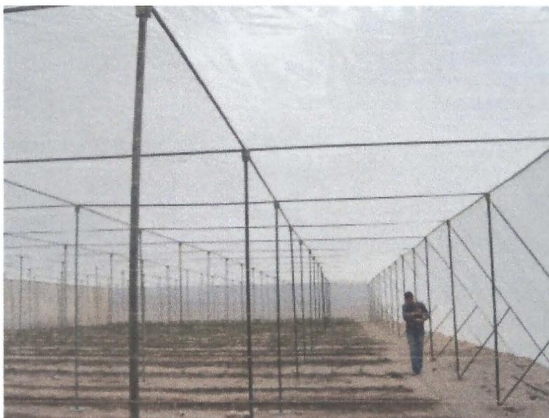
Figura 8. Pared suroeste del invernadero con el cambio de ángulo y el refuerzo estructural para soportar el viento predominante en la zona.
