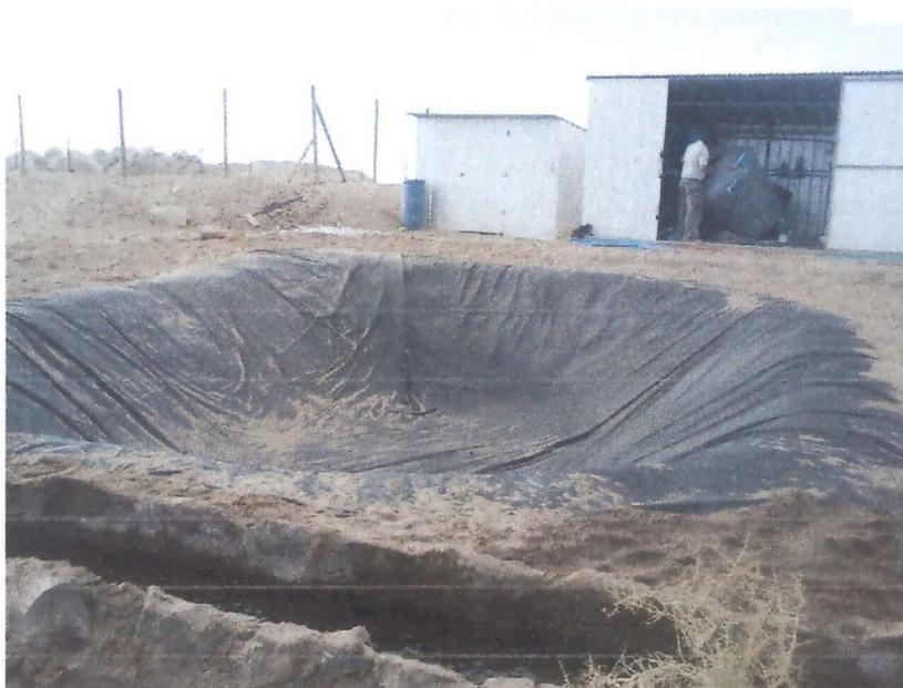
Figura 41. Pozo de bombeo terminado con recubrimiento de HDPE.
