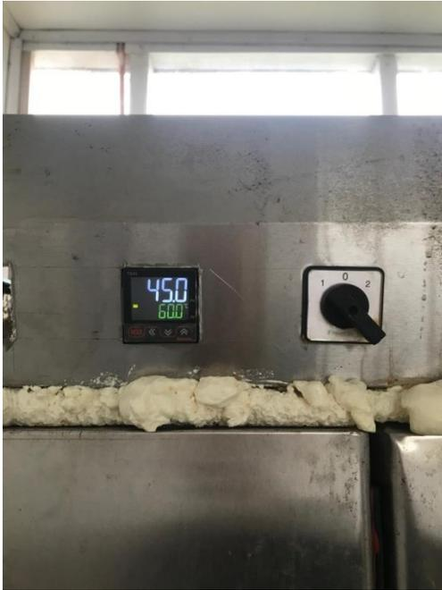
7- Controlador de horno deshidratador adaptado.
