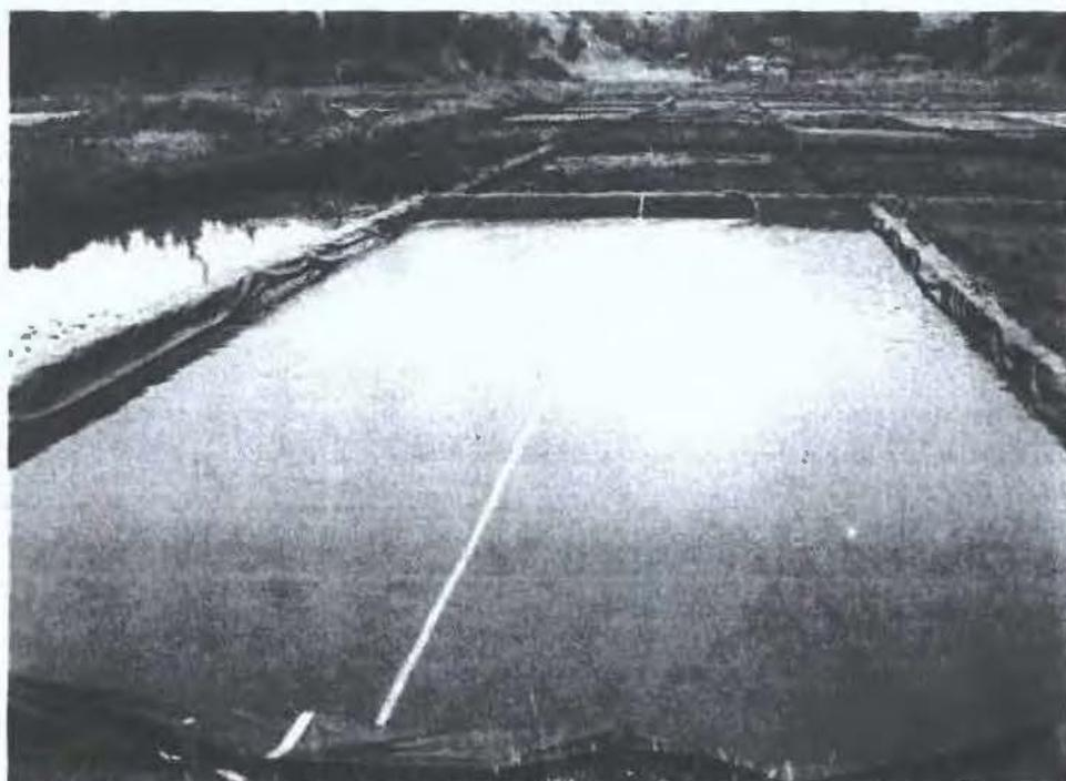
Figura 4. Estanque recubierto con mangas de polietileno de 4 m de ancho traslapadas y selladas con cinta para impermeabilización de tuberías.
