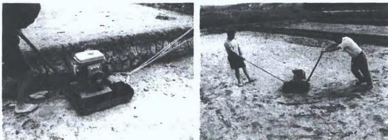
Figura 3. a) Placa compactadora. b) Compactación de los estanques para prevenir la pérdida de agua por infiltración.
