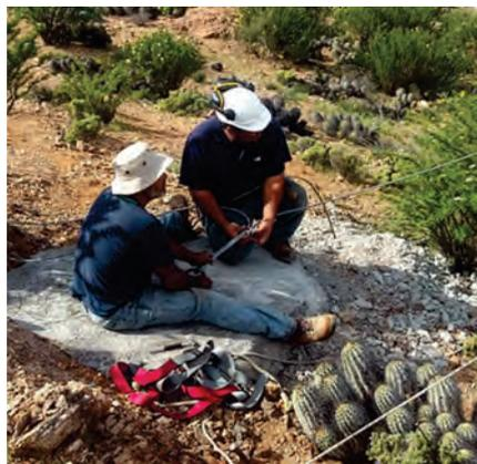
**Figura 2.27.** Tendido de cables de acero y amarre a sistema de anclajes.
