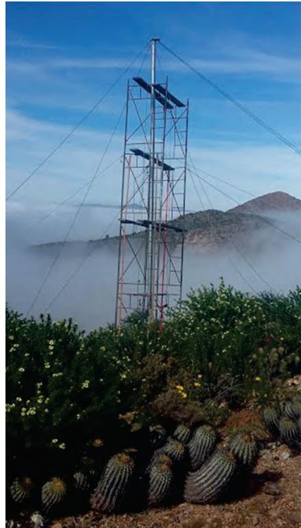
**Figura 2.26.** Uso de andamios en la instalación de mástiles del atrapanieblas.
