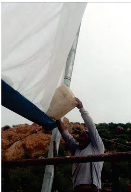
**Figura 2.39.** Instalación de cartucho filtro de malla en cabecera de ducto de agua.
