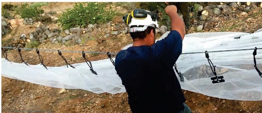
**Figura 2.29.** Fijación de la malla a cables tensores del sistema atrapanieblas.
