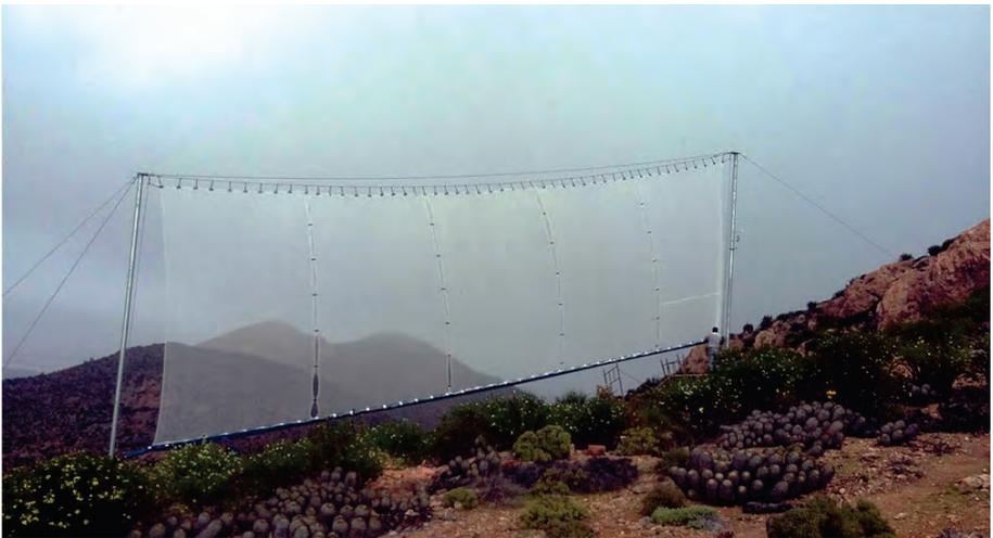
**Figura 2.33.** Atrapanieblas de moderna estructura instalado en Cerro Los Perales de Taltal.
