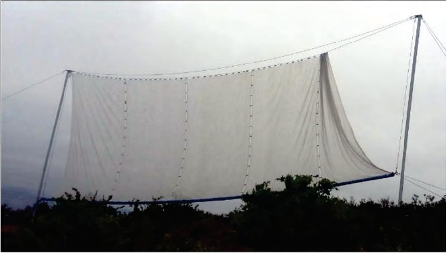
**Figura 2.37.** Malla desconectada de broches, causado por ráfagas de viento sobre lo normal.
