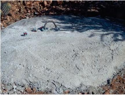
**Figura 2.24.** Fundación y sistema de anclaje para los tensores del atrapanieblas.
