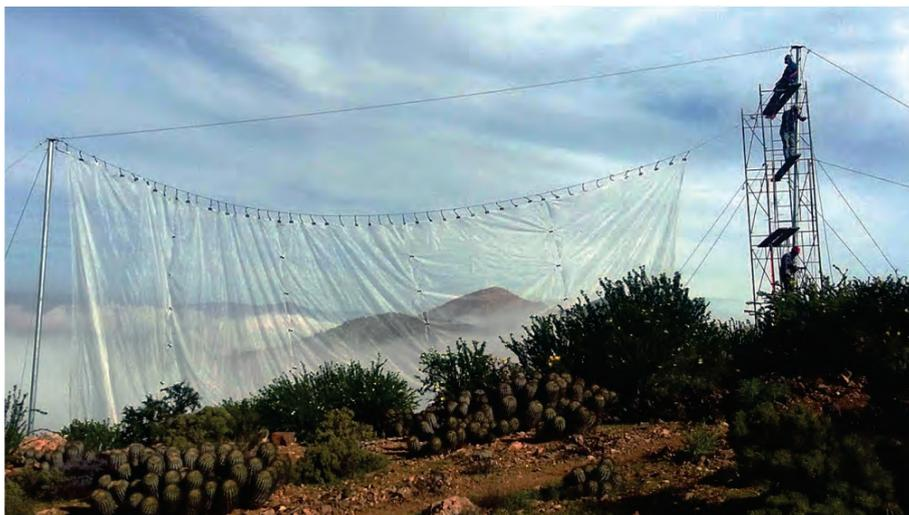
**Figura 2.30.** Izamiento de malla en el atrapanieblas.
