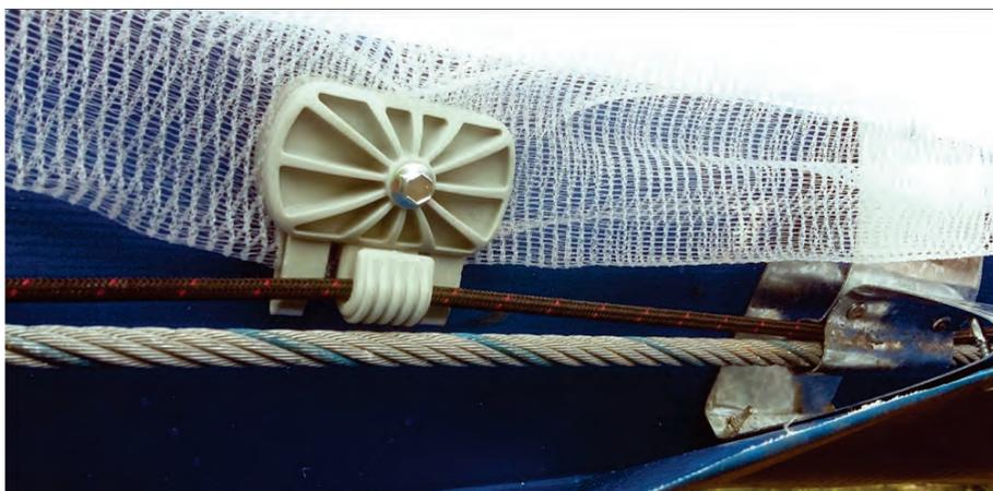
**Figura 2.31.** Broches de enganche de malla y cuerdas elásticas del sistema atrapanieblas.
