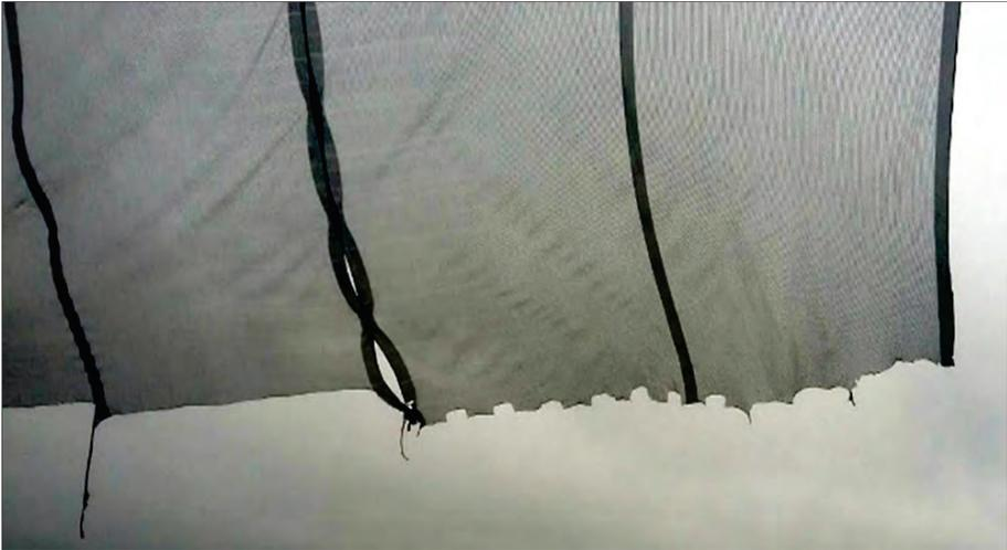
**Figura 2.36.** Daño por viento o fatiga de material por efecto de la radiación UV en uniones a tensores
