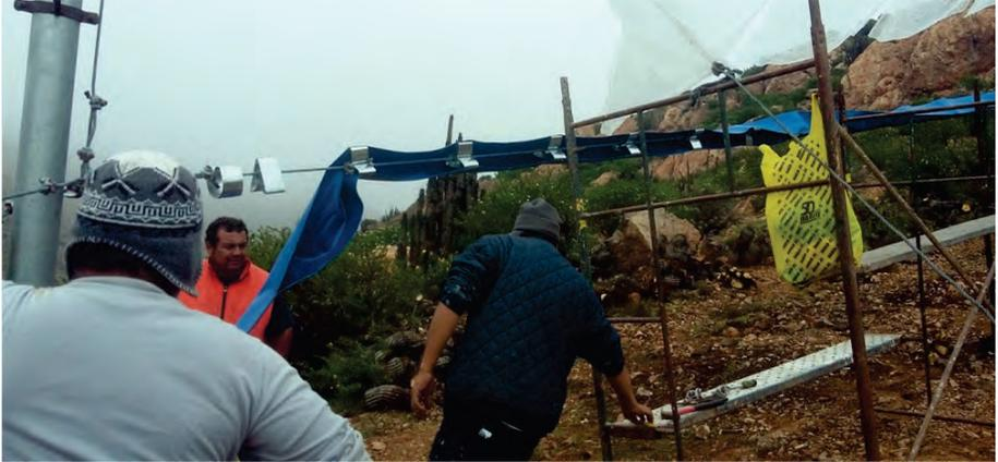
**Figura 2.32.** Instalación de canaleta receptora de agua capturada por las mallas del sistema atrapanieblas.
