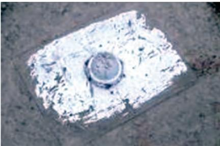
**Figura 2.25.** Fundación y estructura de apollo (rótula) de los mástiles del atrapanieblas.
