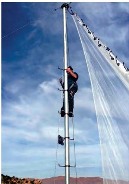
**Figura 2.34.** Ajuste de cables tensores en la parte aérea mediante sistemas de escaleras mecano.
