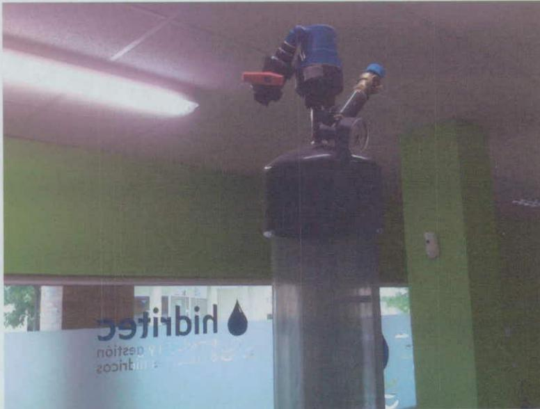
Finalmente indicar que la salida de agua ozonizada para su distribución a riego no podrá ser por la parte superior del tanque como está instalado en estos momentos ya que entonces no habría acumulación de aire, sino que se arrastraría a la red de distribución generando problemas de aire y golpes de ariete. También conviene que la tubería de salida salga de forma recta y no en ascenso para luego volver a descender, evitando así que se acumule aire en tramos de tubería.
