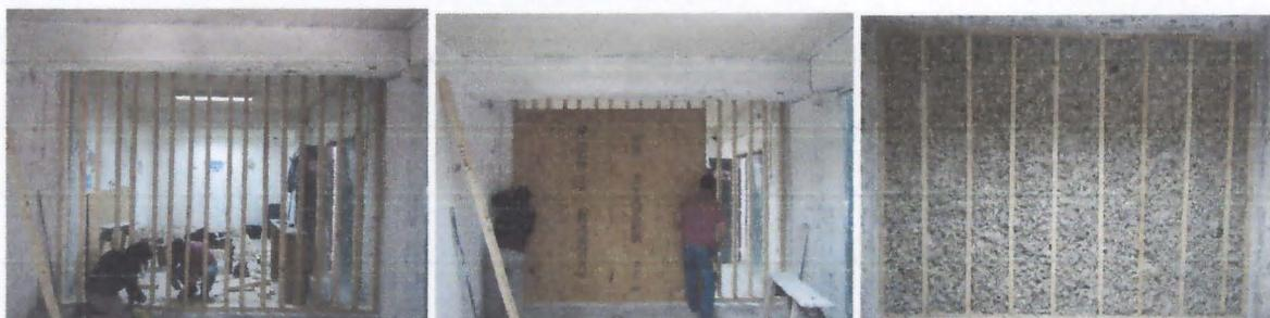
Fotos: Lanarq, construcción solución constructiva tabique acústico, laboratorio IDIEM, Santiago
