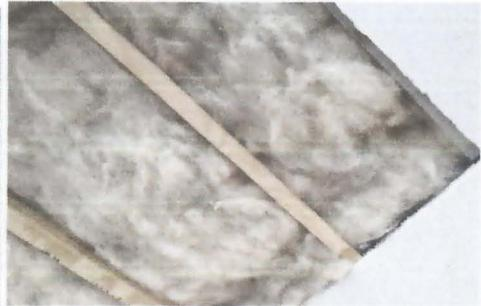
Foto: Lanarq, aplicación de mantos en cielo modulo
