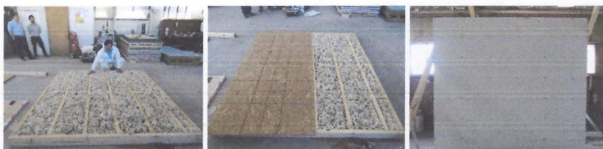
Fotos: Lanarq, construcción solución constructiva tabique fuego, laboratorio IDIEM, Santiago
