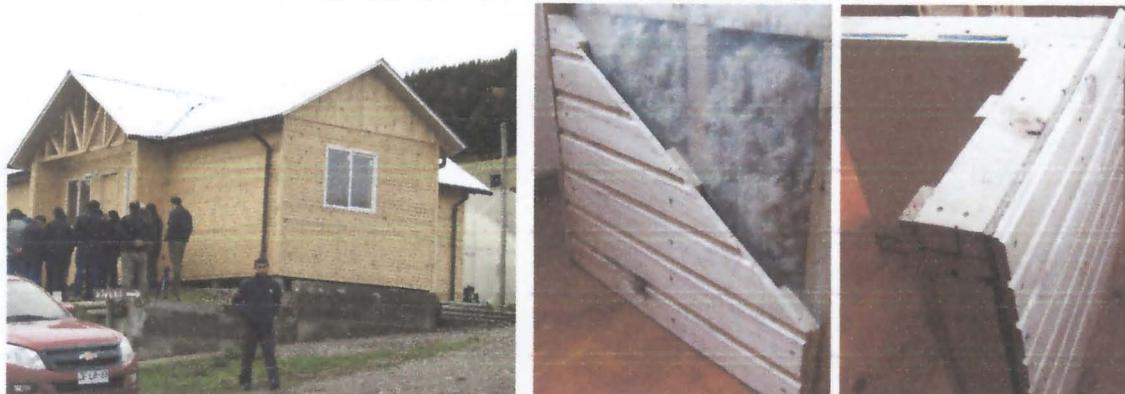
Foto: Lanarq, vivienda construida con madera pino de la zona. Detalle de tabique propuesto.
