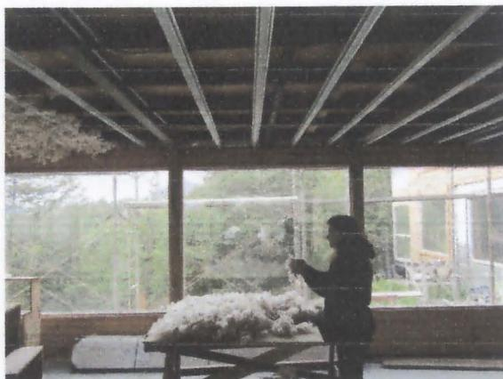
Foto: colocación de lana de oveja a granel, 30 kg/m<sup>3</sup> mediante técnica a mano con apoyo de subestructura de lienzo de nylon de pesca para evitar caída durante la instalación.
