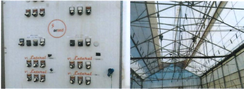
Parte de la automatización que tienen integrada dentro de sus invernaderos, están los sensores de humedad y temperatura, los cuales, dependiendo de las indicaciones que se establecen en la computadora, abren y/o cierran las ventanas de los invernaderos, activan los aspersores, activan los humidificadores, se deslizan las pantallas de sombra, etc.
