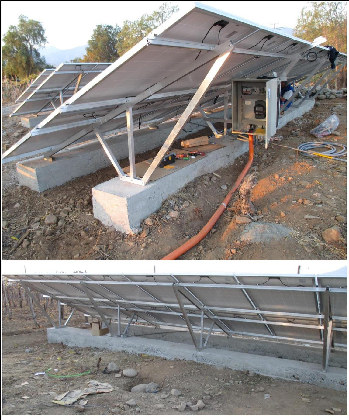
Ilustración 2: Instalación de Estructura, Paneles e equipos eléctricos
