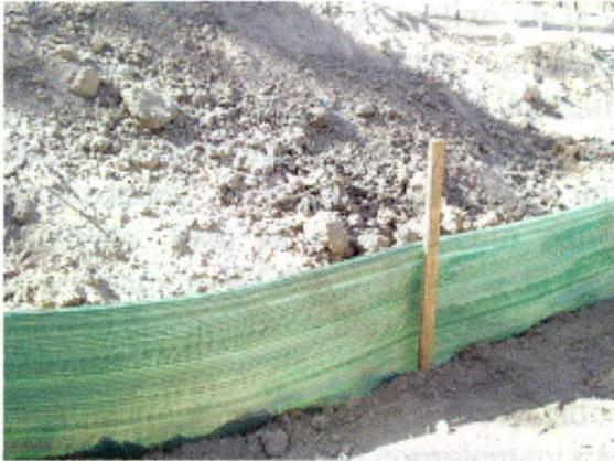
Figura 3. Tecnologías y obras de ingeniería utilizadas en conservación de suelo vistas en terreno. Geotextil de coco, red de alambres y malla de control de sedimentos.
