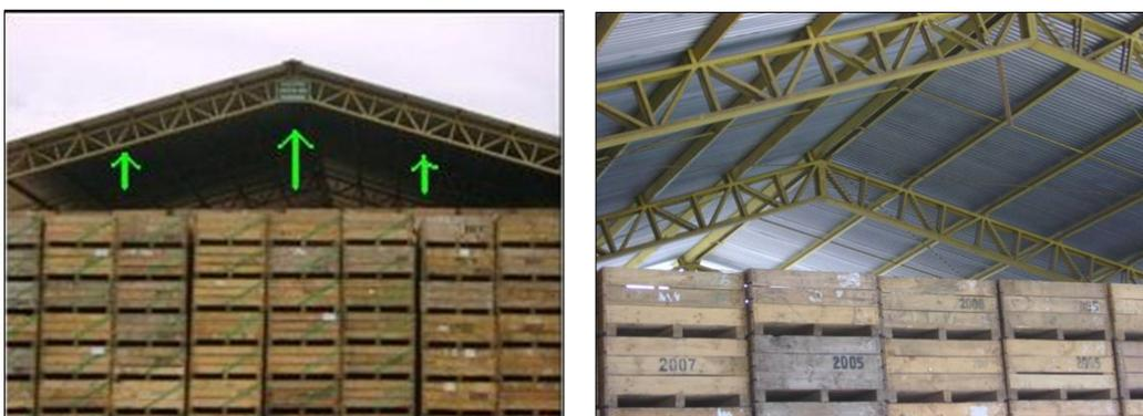
**Figura 1.** Distancia entre los bins superiores y el techo del galpón para permitir una adecuada circulación de aire.
