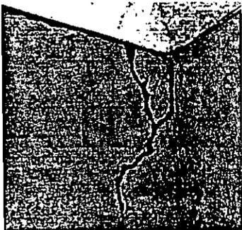
Foto 14. Tubos de suelo en parte alta de una habitación construidos por *Reticulitermes flavipes*.
