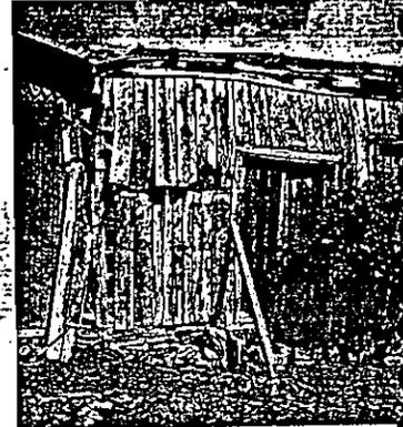
Foto 5. Viviendas con daño de *Cryptotermes brevis*.
