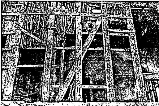
Foto 13. Daño termita en estructuras de vivienda. Carrizal Bajo
