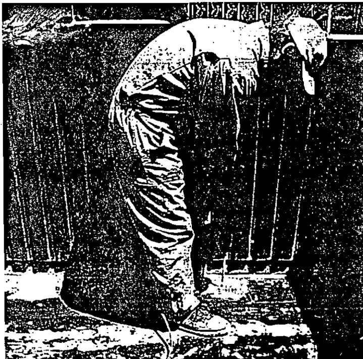
Foto 1. Perforación de piso para la inspección de insecticida en el suelo.
