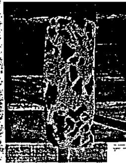
Foto 7. Viga con galerías de *Cryptotermes brevis*.
