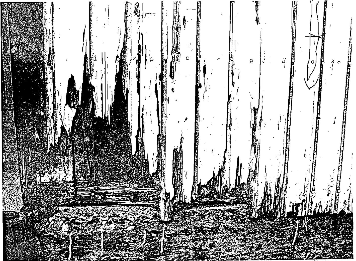
Foto 13. Daño de *Reticulitermes flavipes*, en pared exterior de una vivienda en Quintero.
