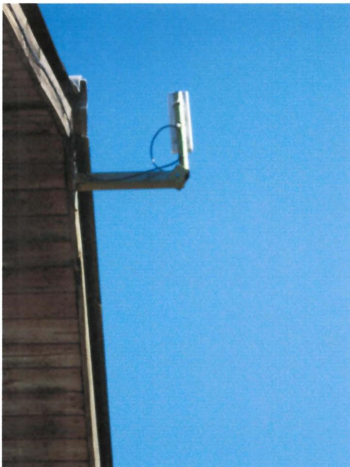
Foto 1: instalación de mástil empotrado en umbral de domicilio con una antena nanostation2
