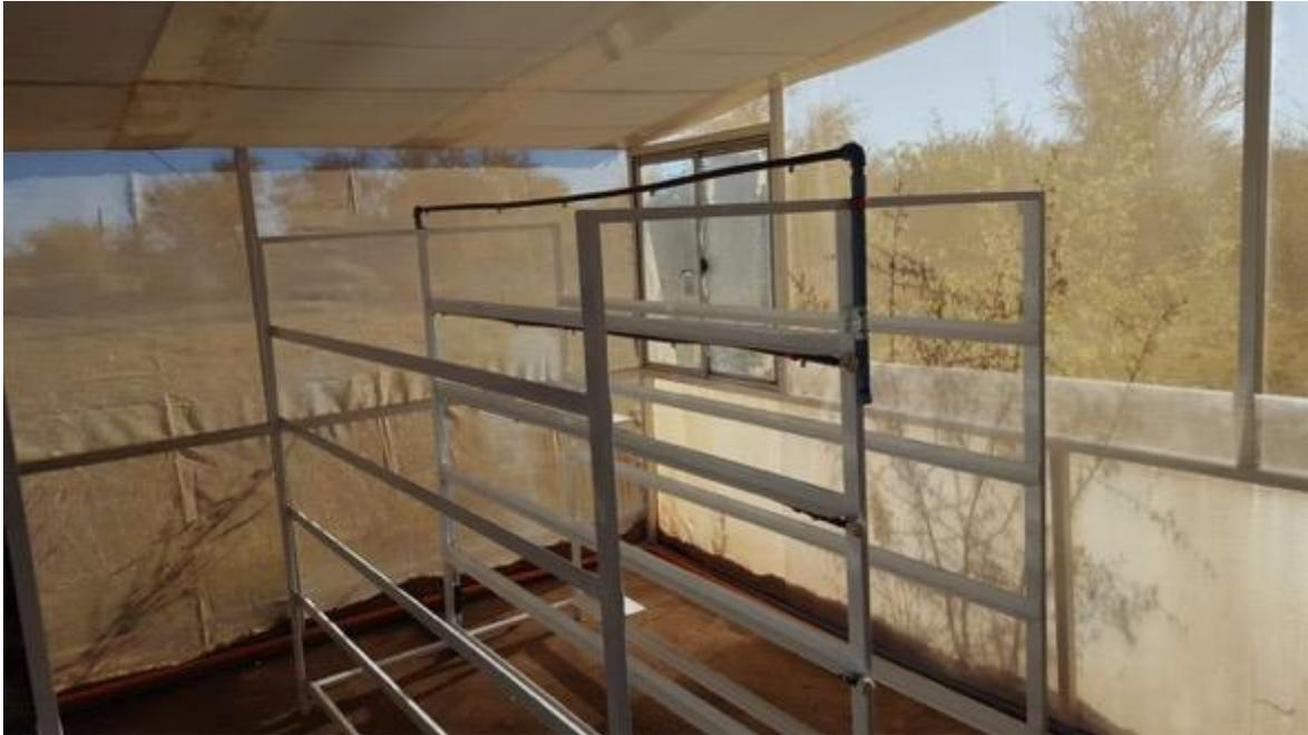
Unidad FVH 1 reparada con mesones pintados con pintura antioxidante de alta resistencia, líneas de nebulizadores al medio de estantes y cambio de boquillas.
