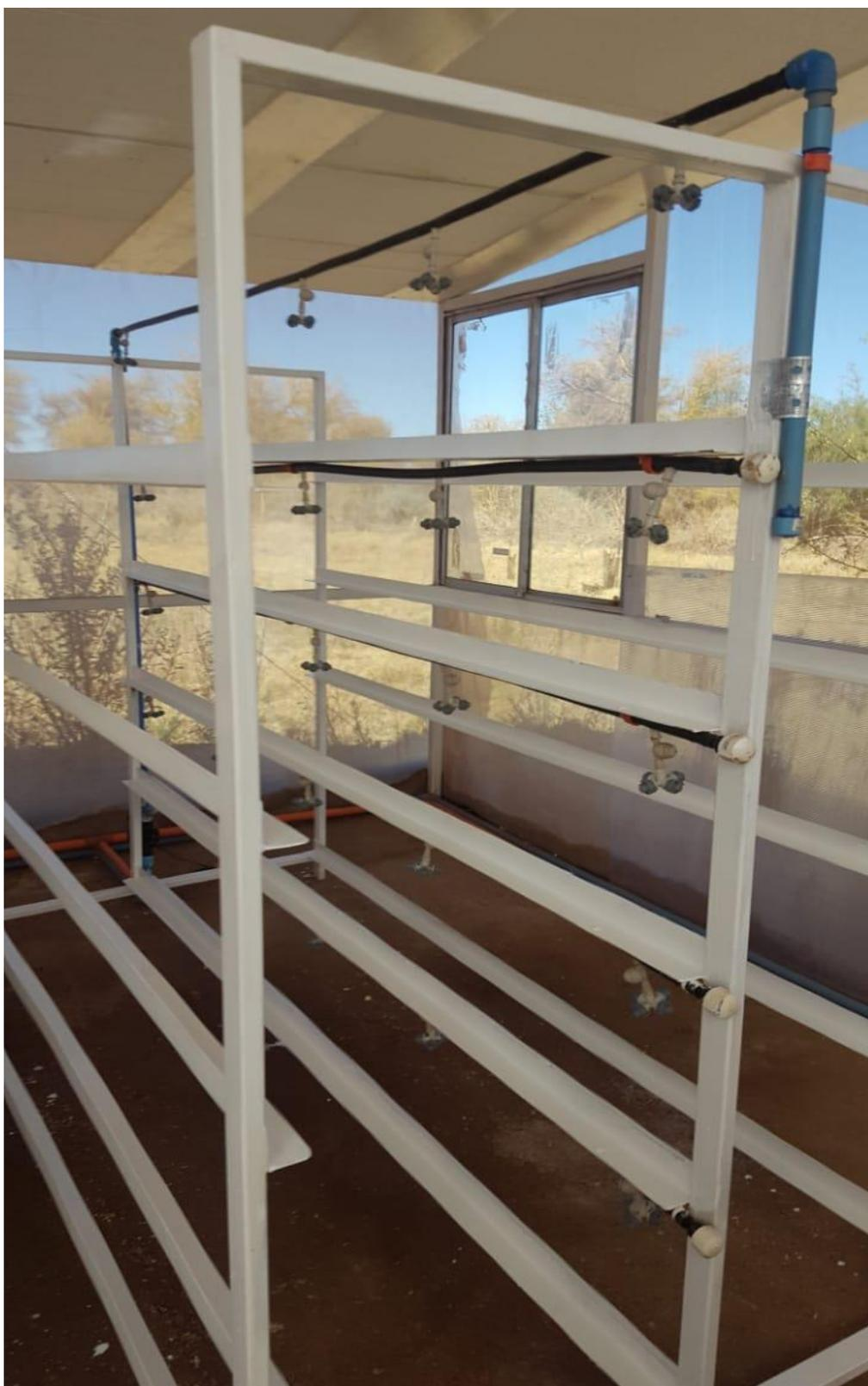
Detalle de estantes modificados para aumentar eficiencia de riego y uso de la energía.
