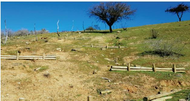
empalizadas longitudinales y para la protección de quebradas y recuperación de zonas erosionadas por cárcavas se utilizan empalizadas transversales, las cuales poseen un vertedero.
