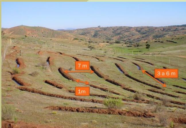
7. Excavar zanja de 40- 50 cm de profundidad. Luego ensanchar parte superior para evitar que las paredes se desmoronen.
