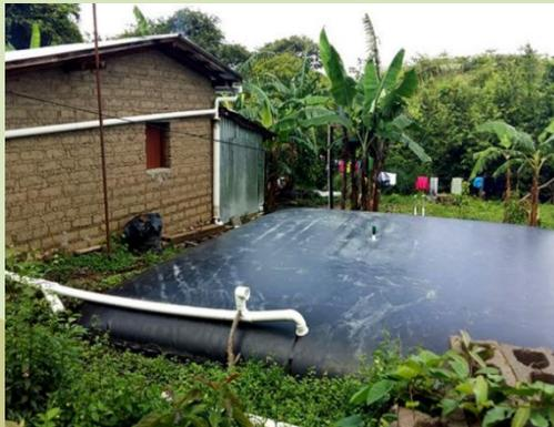
Para la captación y la conducción se usan usualmente canaletas de PVC y la acumulación se puede hacer con estanques de polietileno, mini-tranques de acumulación o cisternas flexibles.
