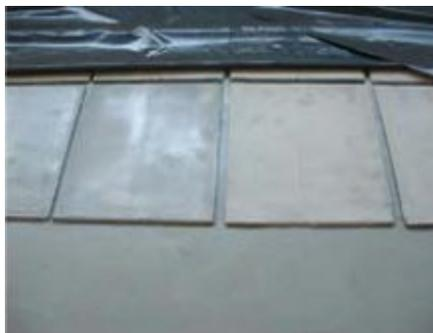
*Figura N° 4.8: Periodo de fraguado para su posterior cubrimiento con plástico.*
