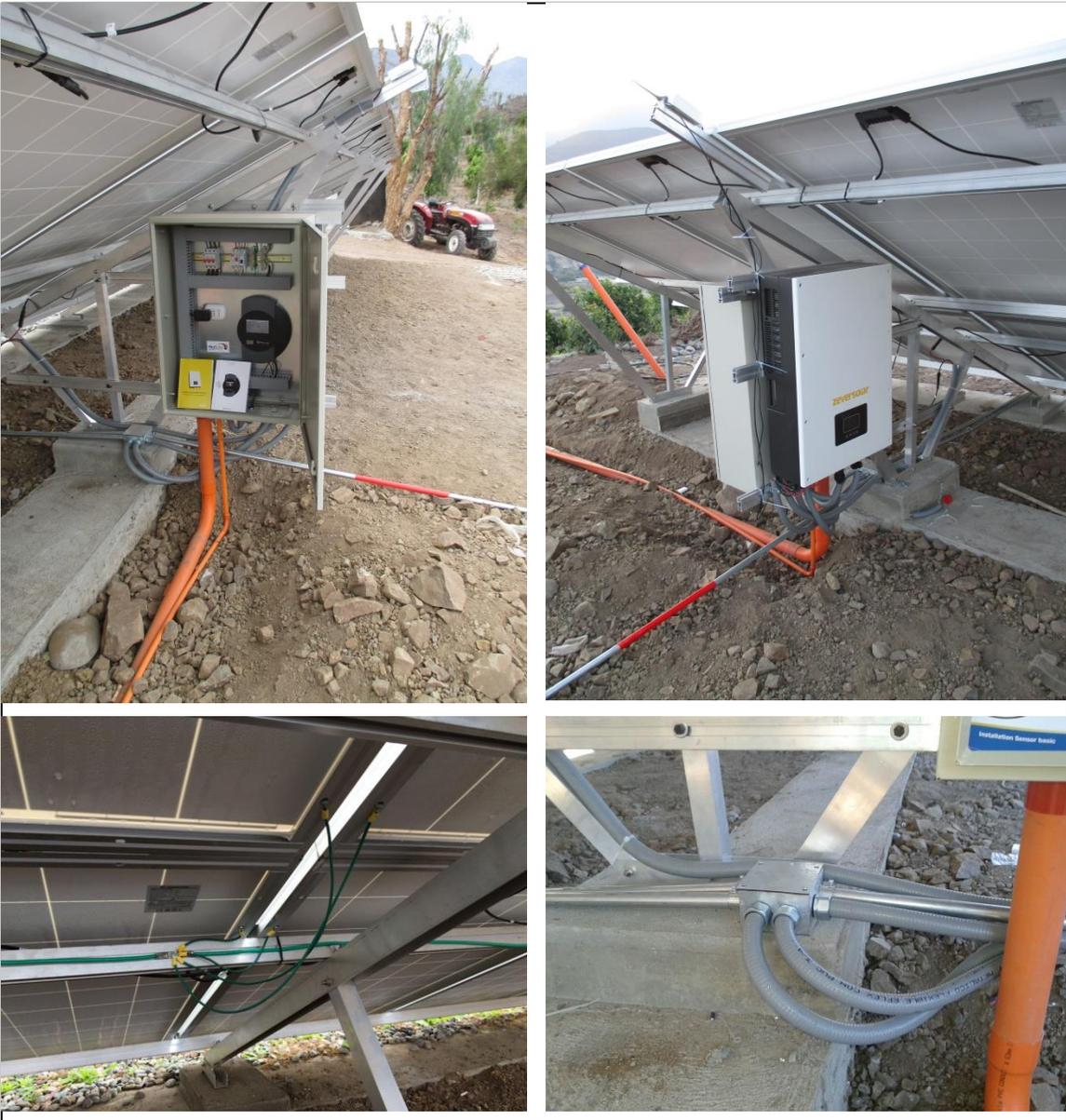
Ilustración 3: Instalación y Cableado de Inversores, Monitoreo, Puesta a tierra
