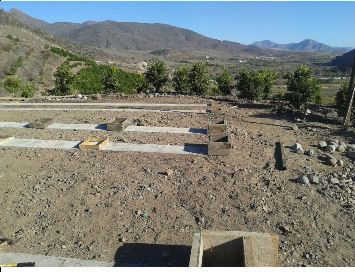
Ilustración 1: Fabricación Bases de Hormigón
