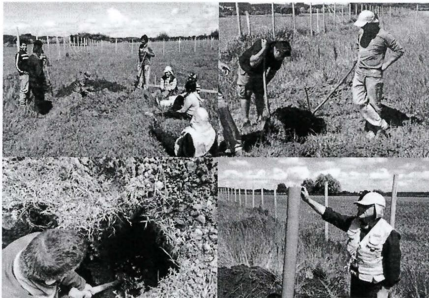
**Figura 1.-** Construcción piezómetro para medición nivel de agua, en vegas de Imperialito
