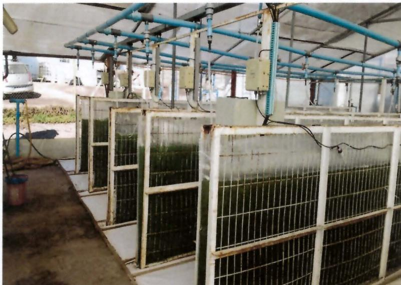
**Figura 4.** Fotobiorreactores cerrados 1 m<sup>3</sup> de capacidad en condiciones outdoor
