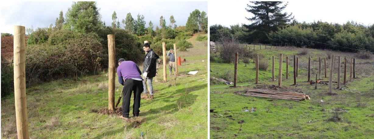
**Figura 5.** Instalación de postes de soporte sistema de protección.
