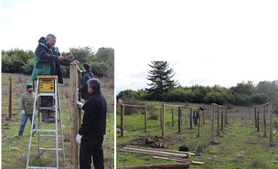
**Figura 6.** Instalación de uniones entre postes.
