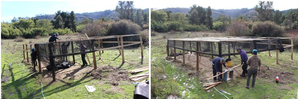
**Figura 7.** Instalación de malla raschel.
