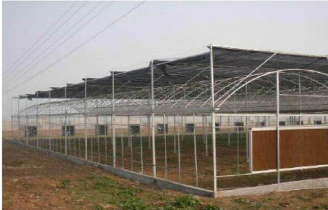
Figura 4. Sistema de ventilación y panel evaporativo.
