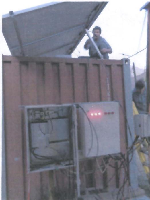
Instalación de conversor fotovoltaico y nuevo cableado de paneles solares
