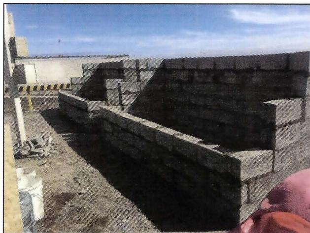
PASO N°4: Impermeabilización. Los primeros 10 cm se deben impermeabilizar con una membrana asfáltica para evitar filtraciones ya que en la parte inferior estará retenida el agua de mar junto con el gravillon, además se pondrá un nylon extra para evitar filtraciones en un 100%. Las paredes superiores se impermeabilizaron con pintura asfáltica impermeable Igol denso.
