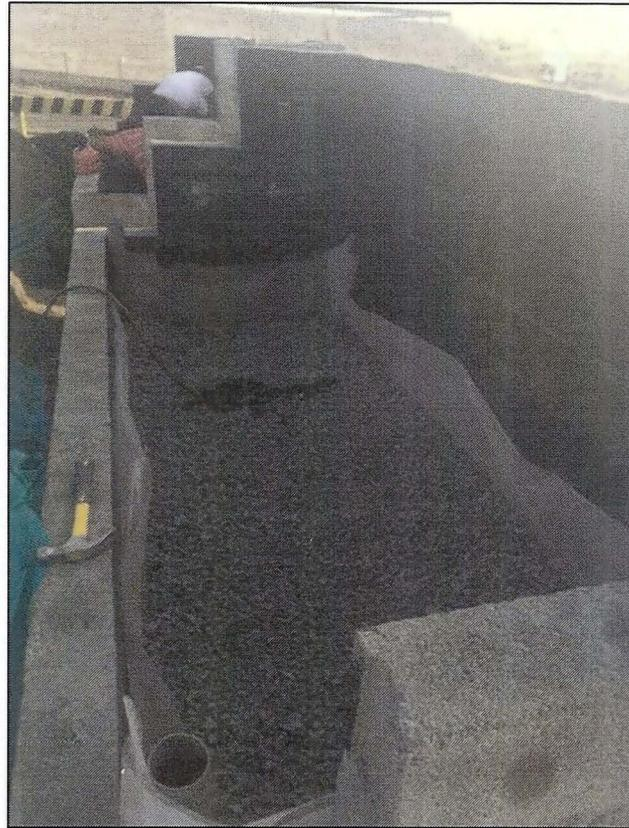
PASO N°6: Para separar el agua de mar y el sustrato, se utilizó una capa de malla anti-hierba y otra de malla rachel, con la finalidad de que el sustrato no sature al espacio del movimiento del agua de mar.
