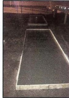
PASO N°2: Levantamiento de la estructura e impermeabilización con una membrana asfáltica para crear el nivel freático.
