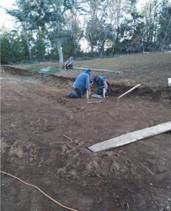
Imagen muestra trabajos de perforación de suelo para fijar los arcos metálicos.
