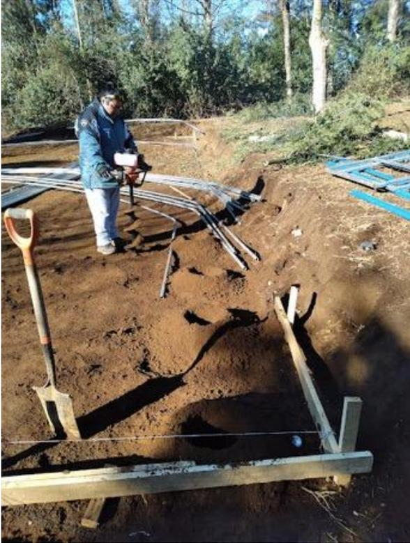
Imagen muestra pilares galvanizados levantados.
