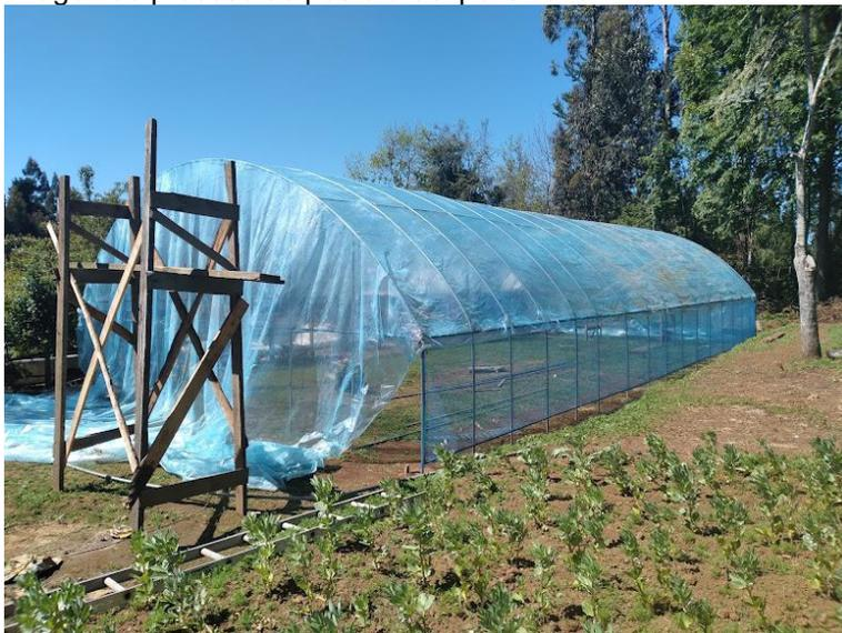
Imagen muestra polietileno instalado.
