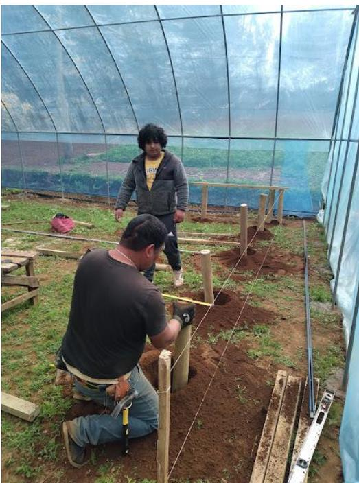
Imagen muestra marcos de soporte del sistema NFT.
