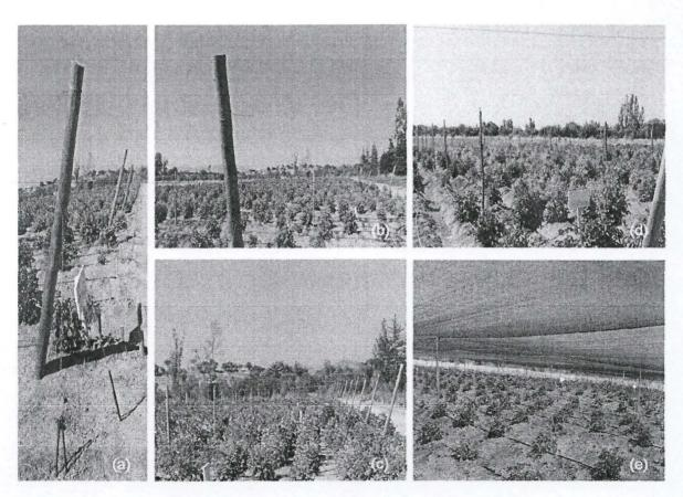
Figura 26. Malla de sombreo, (a): detalle del poste esquinero anclado al suelo, (b): distribución de los alambres desde el poste esquinero, (c): estructura tendida entre los polines y los postes interiores, (d): postes interiores cada 8 m en cuadrado, (e): malla tendida.
