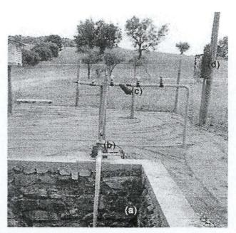
Figura 15. (a): fuente de agua, (b): unidad de bombeo, (c): cabezal de control y (d): caja del programador eléctrico (llegada corriente eléctrica).
