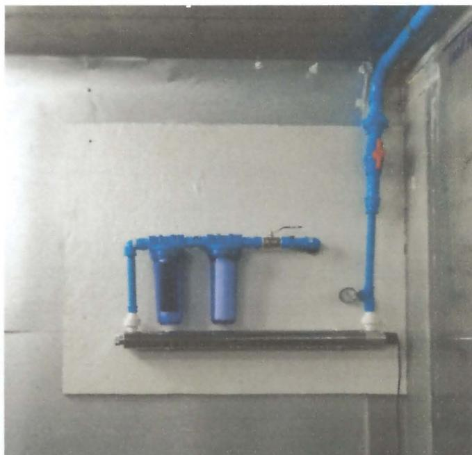
**Figura 19.** Sistema de triple filtración; filtro de malla, carbón activado y aplicación de luz ultra violeta. Agua bombeada desde el estanque en el exterior.
