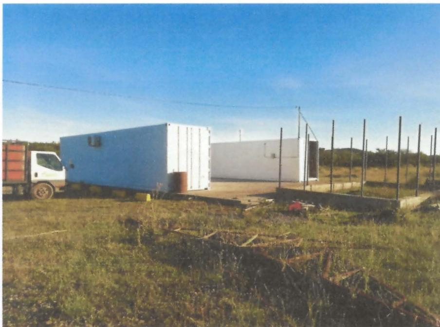
**Figura 11.** Diseño basado en 2 contenedores. Se pretende construir un techo entre ellos para bodega y terminar una sala de procesos en la parte anterior. (Anexo 3)
