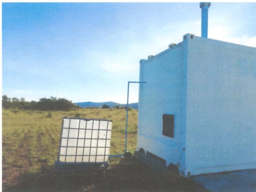
**Figura 20.** Vista posterior del contenedor. Sistema de inyección de agua, compuesto por una bomba y estanque de 1000 lts. Puerta para la carga de leña desde el exterior para estufa dispuesta en el interior.
