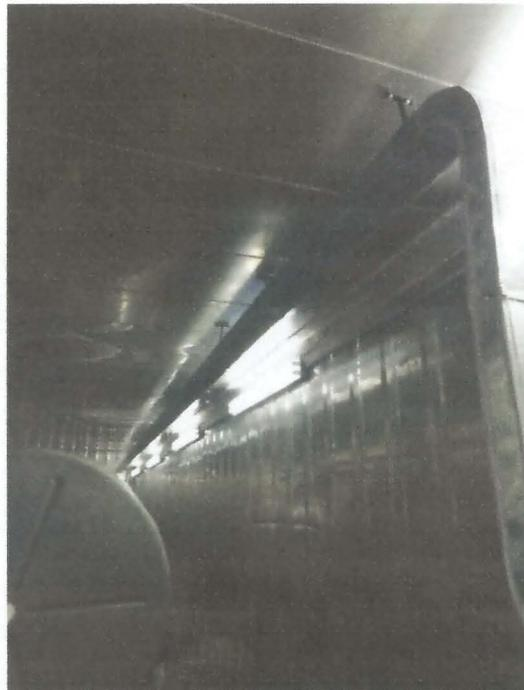
**Figura 23.** Ducto conductor del calor a la zona anterior del contenedor.
