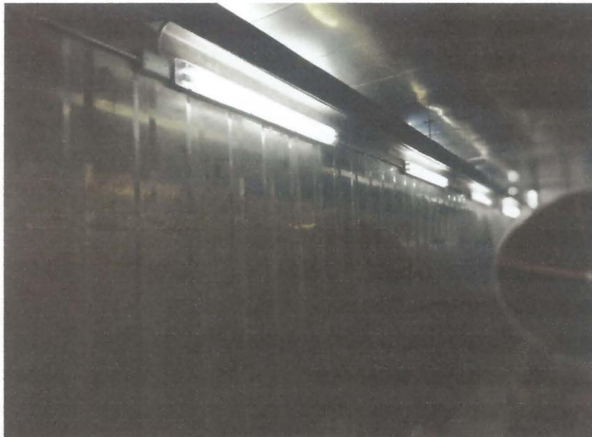
**Figura 25.** Sistema lumínico compuesto por equipos estanco led. Se requiere corrección de altura.
