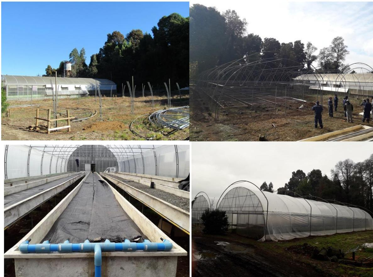
**Figura 1.** Set fotográfico que muestra avances en levante. A) Emplazamiento e inicio de levante de arcos; B) Arcos ya estructurados; C) Cubiertas y frontones instalados, invernadero más cercano es de aclimatación y el otro para plantas madre; D) Interior del invernadero para plantas madre con sus canaletones en proceso de instalación (foto 1°) jul.-20
