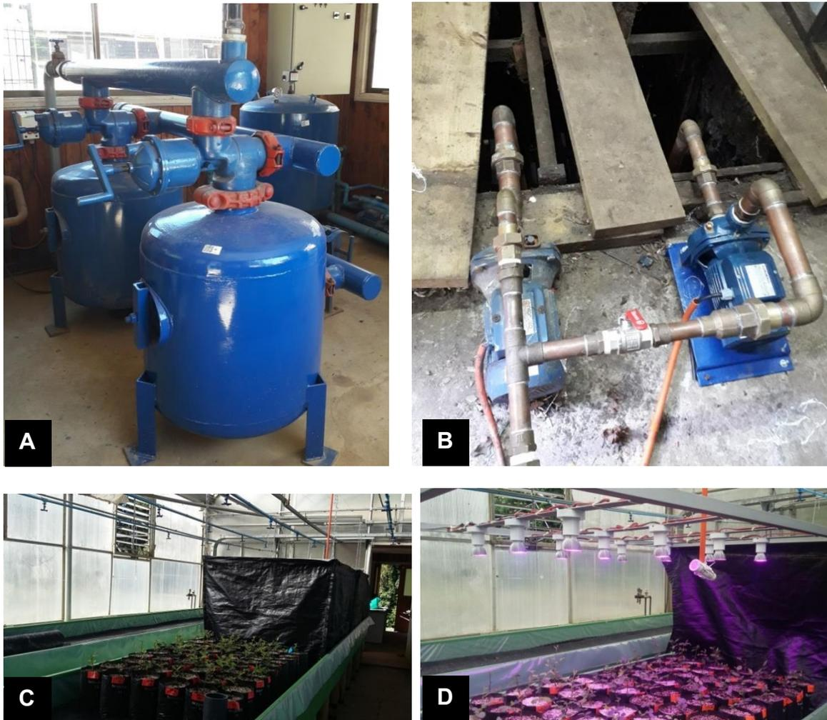
Figura 2. A: Reparación de estanque, además incluye cambio de arena tipo cuarzo a ambos estanques. B: Instalación de segunda bomba de abastecimiento general, todas las conexiones cambiadas y confeccionadas en cobre. C: Vista general de invernadero de policarbonato donde fueron instalados los ensayos de luz para la formación y manejo de plantas madres. D: Detalle de tratamiento de luz de amplio espectro en plantas madres.
