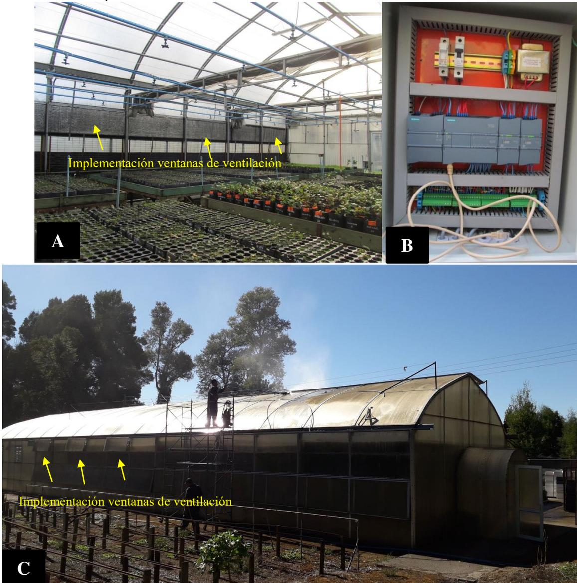
**Figura 2.** A) Vista general invernadero de policarbonato habilitada para enraizamiento de miniestacas, se puede observar la implementación de líneas de riego tipo fogger, ventanas superiores para evacuación de aire. B) PLC instalado, unidad de control que permite la programación de riegos y monitoreo de condiciones ambientales de forma remota. C) Vista exterior invernadero de policarbonato (limpieza techo y nuevas ventanas de ventilación).
