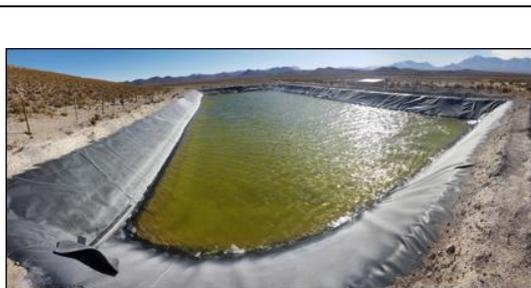
Figura 2. Estanque de acumulación de 2000 m<sup>3</sup>.
