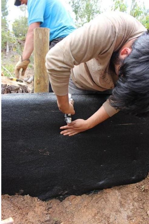
**Figura 6.** Instalación de malla rache.
