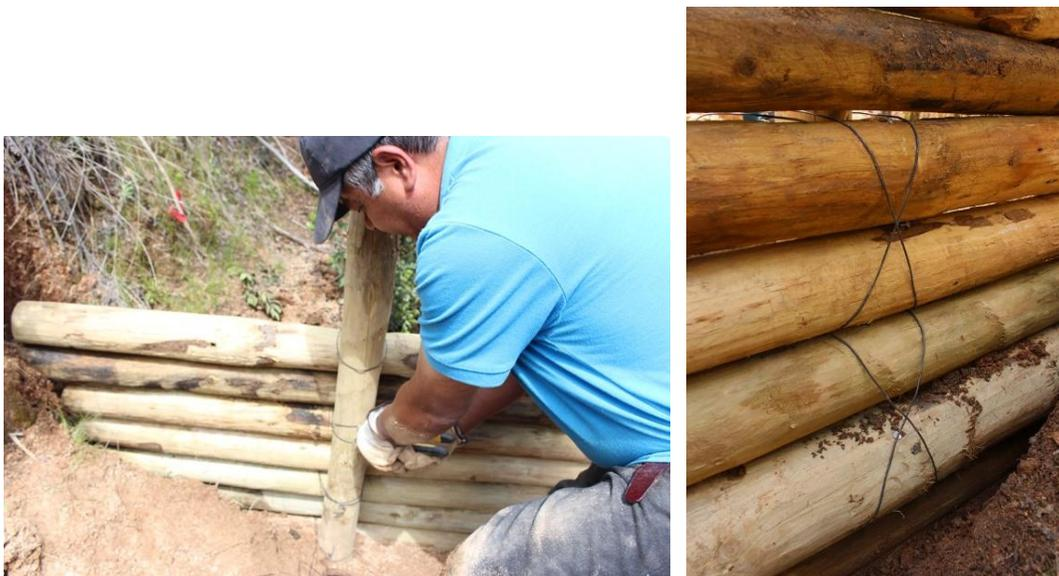
**Figura 5.** Polines montados y fijación a polines verticales.
