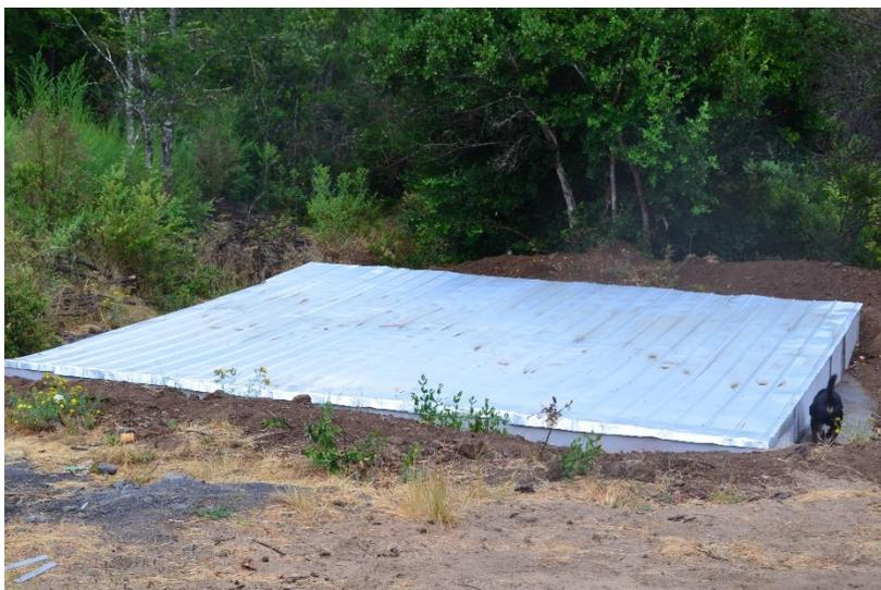
**Figura 11.** Pozo acumulador de aguas lluvia con cubierta protectora.
