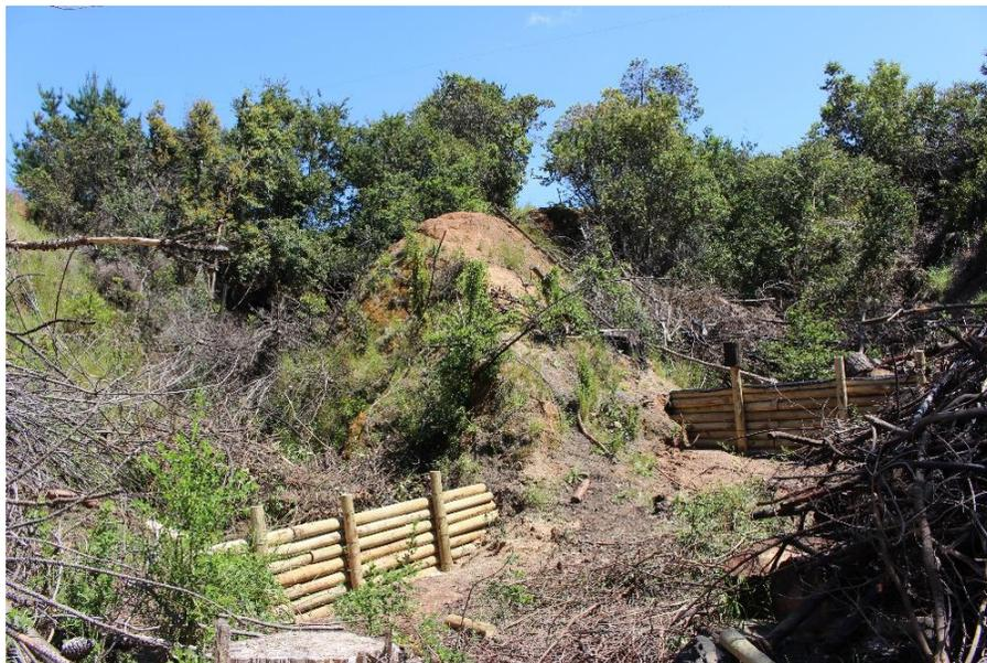
**Figura 7.** Vista general de cárcava con diques construidos.
