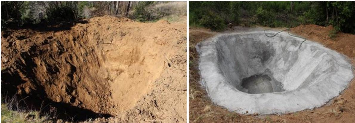
**Figura 10.** Pozo acumulador con revestimiento de paredes interiores.
