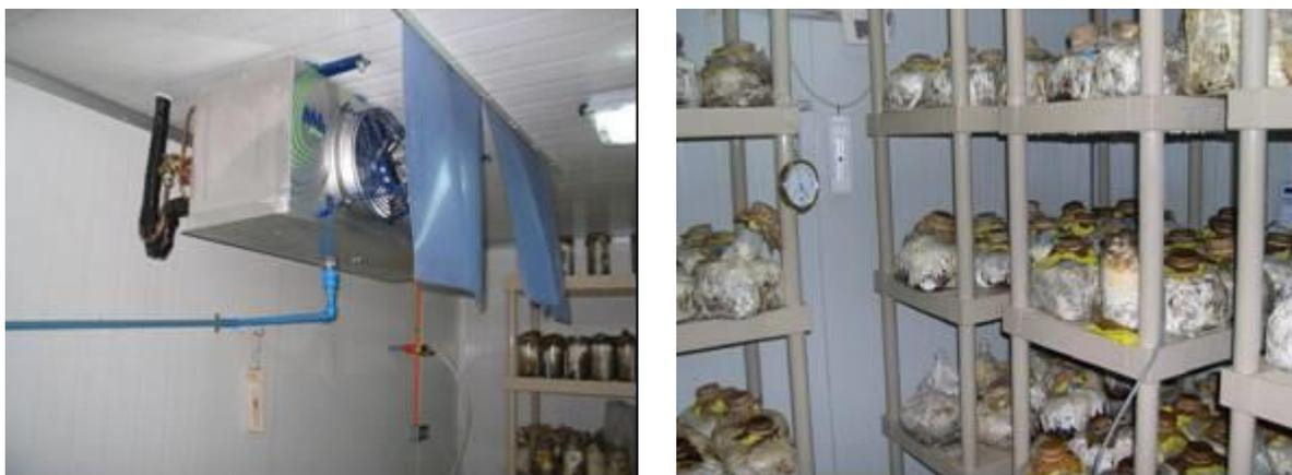
Foto 14. Sistema de ambientación de módulo para la entrega de frío y humedad.
