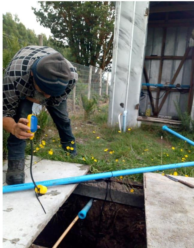
Una vez resuelto los detalles de funcionamiento del espacio de captación se instaló el sistema de flotadores para lograr automatizar tanto el llenado como la parada del suministro de agua al estanque desde el espacio de captación. Ahora el sistema funciona en forma automática.
