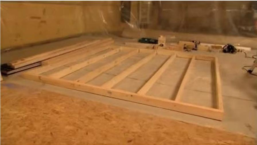
Para esto hacemos dos estructuras con vigas de 1,5 completas hacer un cubículo como muestra en la imagen para soporte de paredes.
