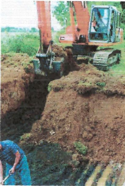
Foto 7: Preparación de un dren tipo zanja.
