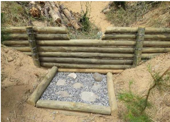
Foto 13. Primer plano de disipador y dique en madera.
