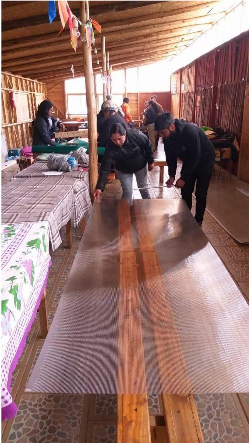
**Imagen 8.** Cuadrilla marcando el policarbonato alveolado para luego cortarlo. Estas piezas van sobre las deshidratadoras como techo y permite que se genere calor como efecto invernadero.
