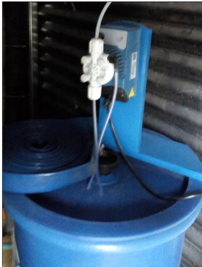
**Imagen 1.** Equipo clorador instalado en bodega exterior de sala de procesos, el cual impulsa el cloro por goteo en el flujo de agua mediante una pequeña motobomba eléctrica.
