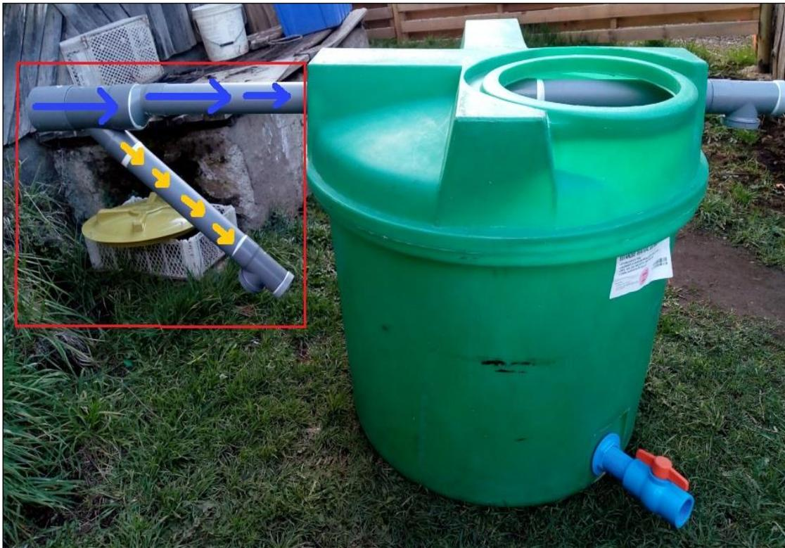
**Imagen 3.** En el recuadro de color rojo se muestra el sistema decantador de partículas, las flechas azules indican el flujo del agua y las flechas amarillas indican el flujo de las moléculas que precipitan.
