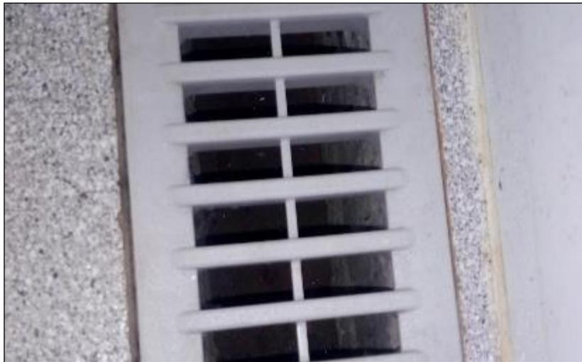
**Imagen 9.** Piso sala de procesos, rendija de drenaje con cubierta plástica para escurrir líquidos del lavado de sala de procesos.
