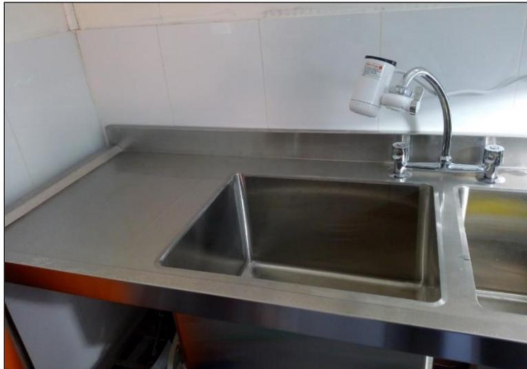
**Imagen 15.** Lavafondo doble de acero inoxidable permite el lavado y el depósito de botellas previo al lavado interior de las mismas. Conectado a la salida de agua se encuentra el sistema de calefacción del agua en color blanco, el que permite alcanzar temperaturas de hasta 80°C.
