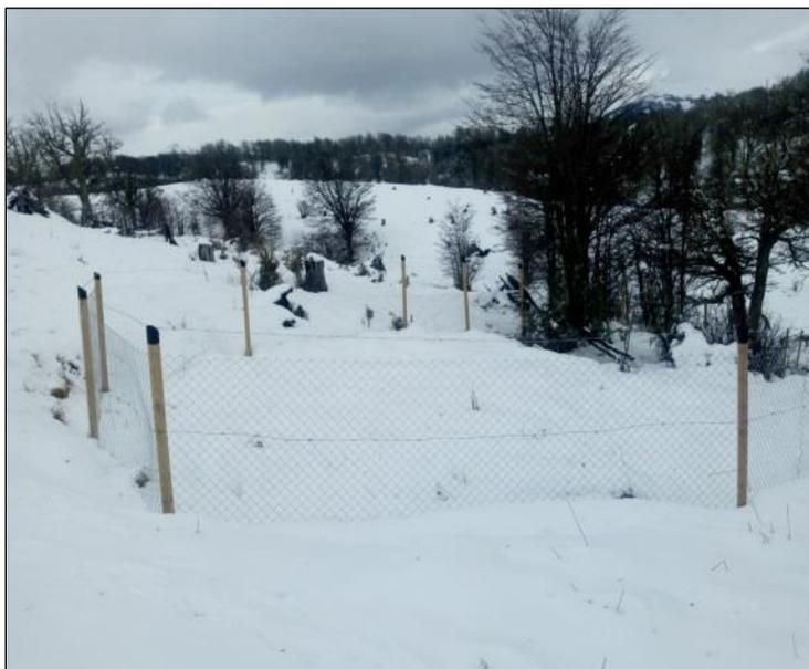
**Imagen 6.** Fotografía de la parte superior del cierre perimetral del recinto del manantial. Tomada desde el exterior. Se observan los polines impregnados con la malla del cierre perimetral. (fotografía tomada en invierno durante una visita de inspección de la instalación.)
