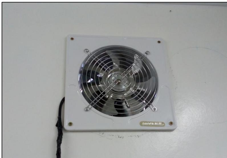
Imagen 9. Instalación de equipamiento de ventilación necesaria que permite la evacuación de vapor del proceso productivo.
