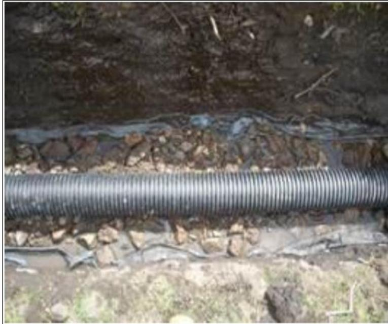
**Imagen 2.** Vista al interior del surco de la tubería ranurada sobre la capa de gravilla y bajo esta la membrana geotextil.
