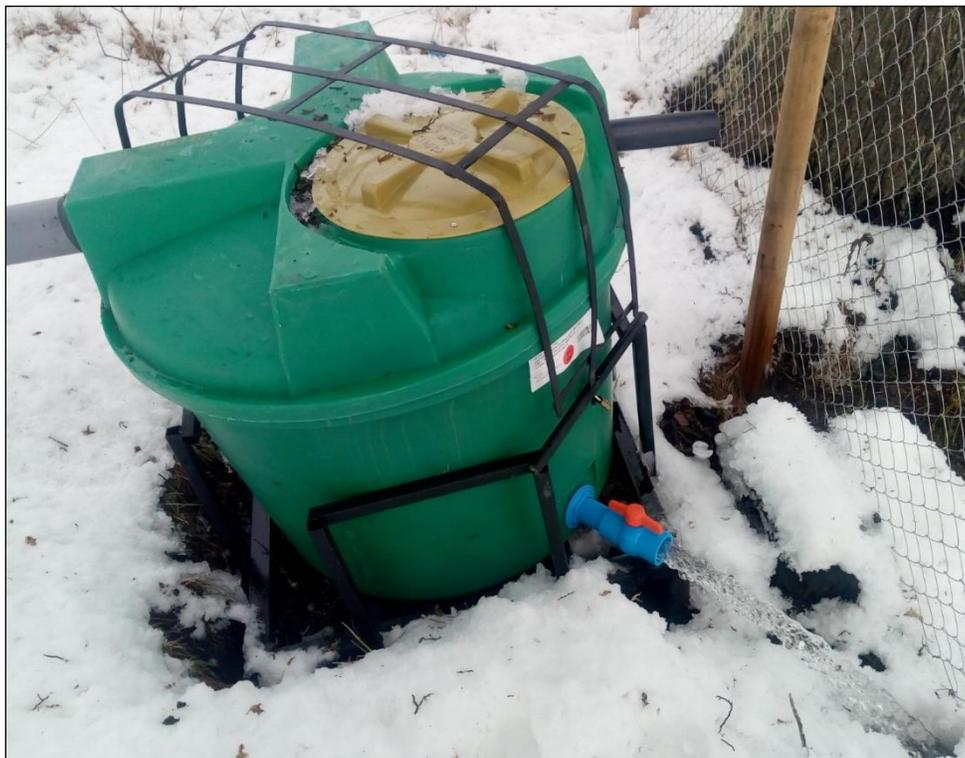
**Imagen 4.** Estanque de acumulación temporal de agua, con llave inferior donde se puede apreciar la salida de agua cristalina y el gran flujo de agua obtenido. (fotografía tomada en invierno durante una visita de inspección de la instalación.)
