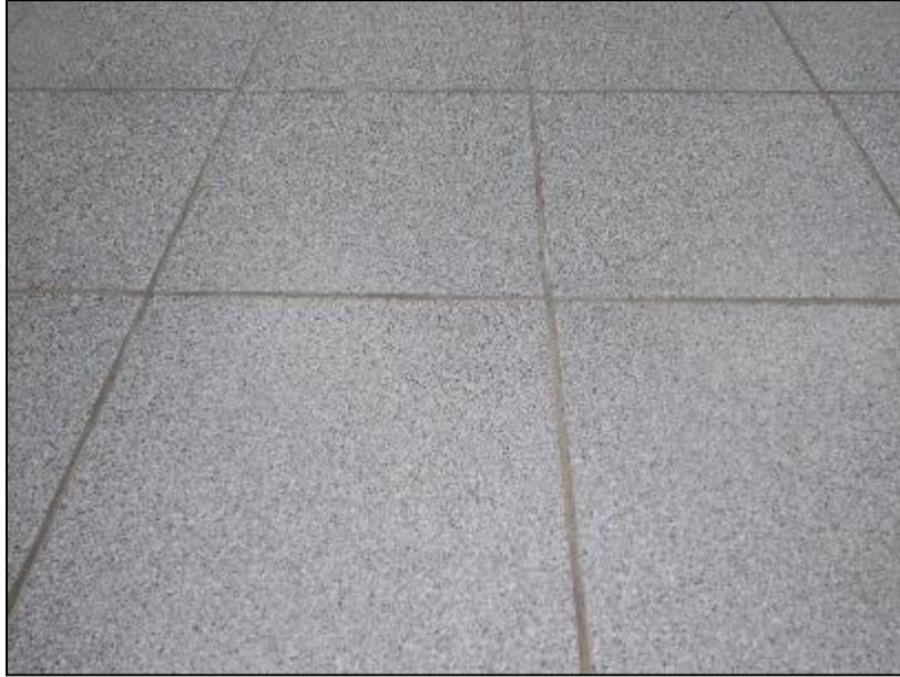
**Imagen 8.** Piso sala de procesos, cubierto con cerámico antideslizante de color claro.
