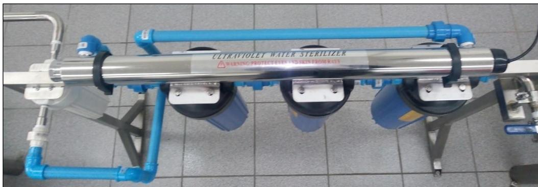
**Imagen 4.** Sistema de esterilización UV, instalado sobre el sistema de filtrado de partículas, este equipo funciona a 220V y emite radiación UV al flujo de agua que circula en su interior.
