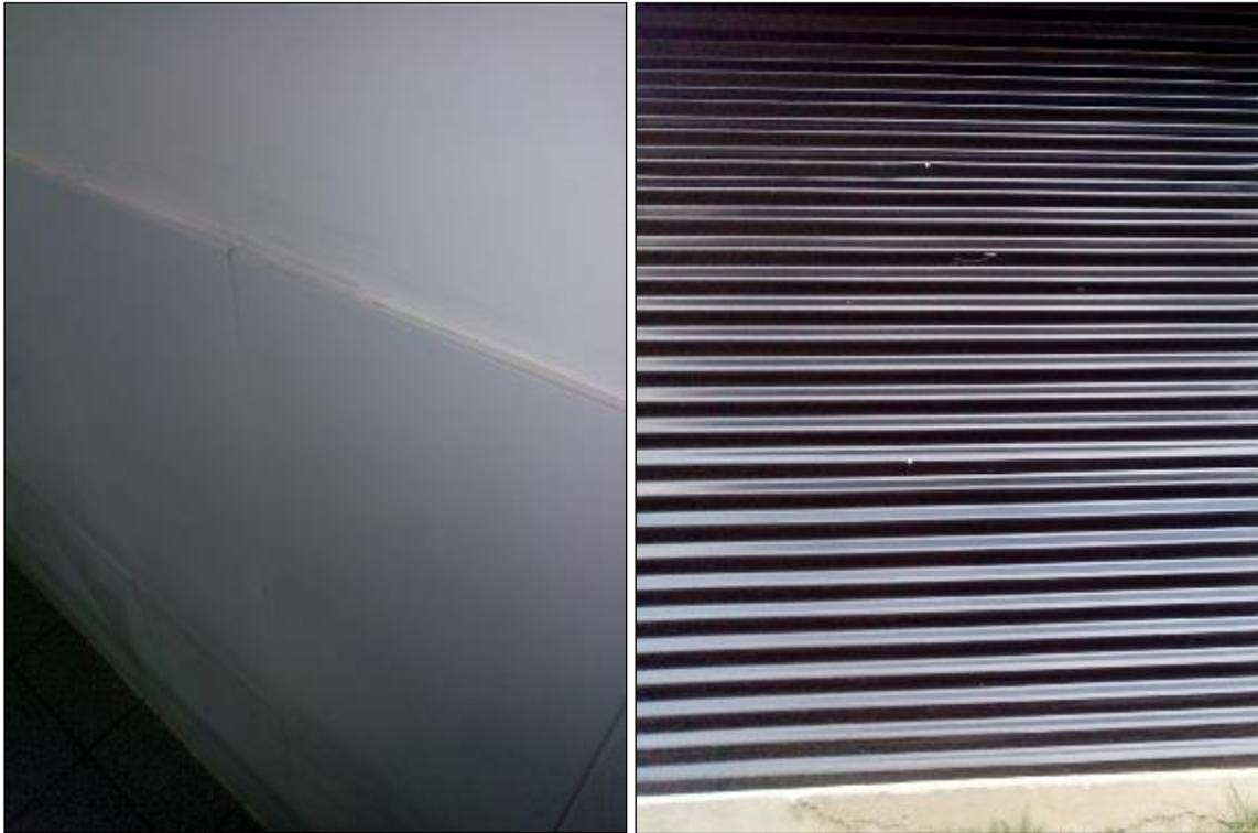
**Imagen 4.** (Izquierda) vista interior de pared de sala de procesos, cubierta con cerámica blanca lavable hasta altura de 1,2mts desde el nivel del suelo, parte superior cubierta con esmalte sintético blanco, lavable. (Derecha) vista exterior de paredes de sala de procesos, cubiertas con zinc acanalado de color negro.
