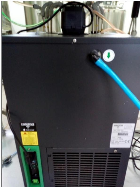
**Imagen 8.** Vista frontal del equipo enfriador, en su interior posee 4 serpentines para enfriamiento del producto, mediante un sistema de refrigeración enfría el agua que cubre los serpentines, logrando la disminución de temperatura.
