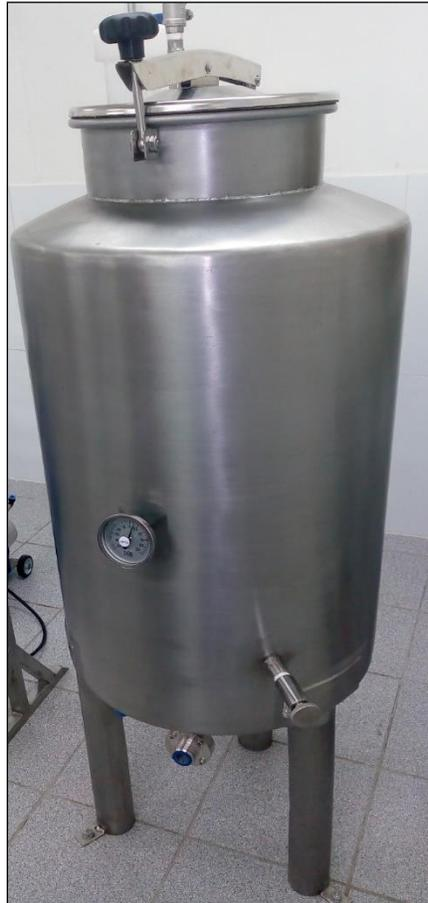
**Imagen 2.** Estanque de acumulación de agua clorada, al interior de sala de procesos.
