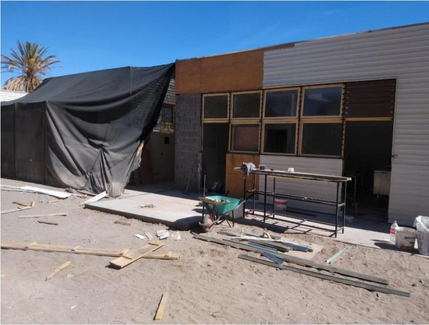
Figura 86. Construcción de radier para ampliación de sala de venta de quesos.
