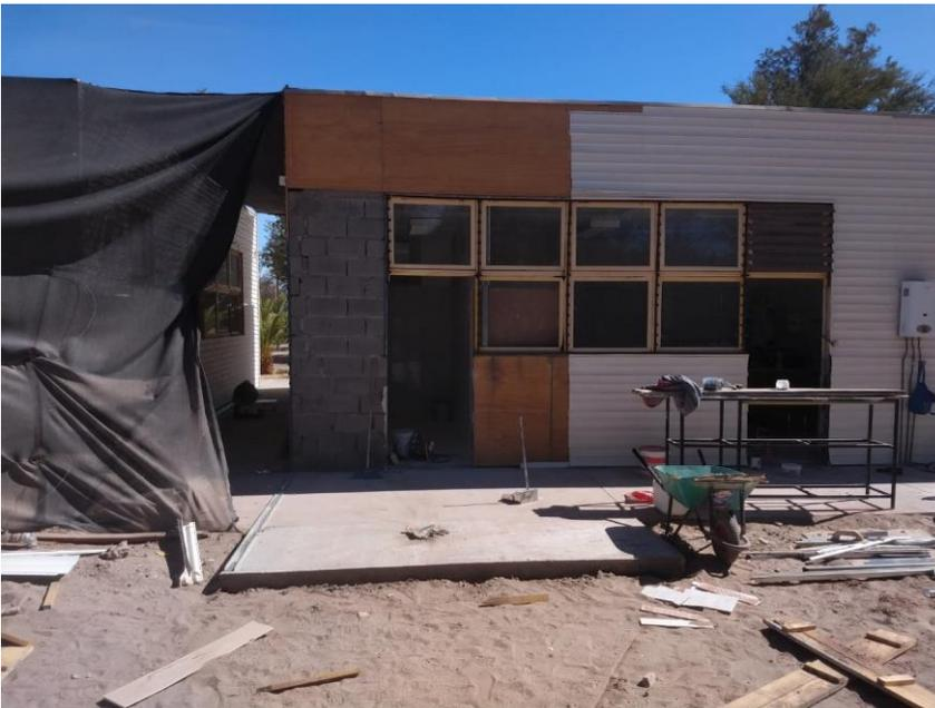
Figura 87. Construcción de radier para ampliación de sala de venta de quesos vista frontal.
