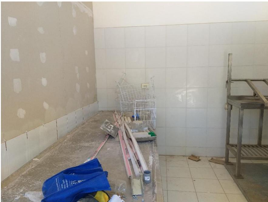
Figura 80. Separación modular de quesería: postura de revestimiento interno.
