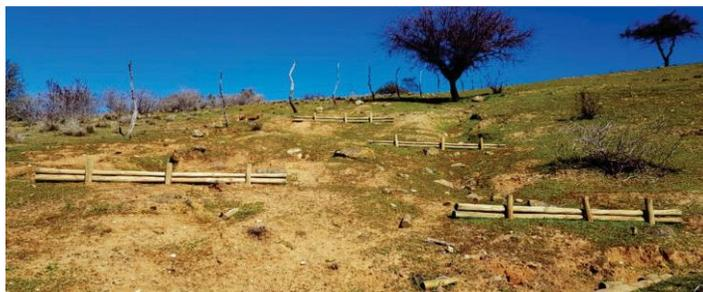
**Figura 4.** Técnica de empalizadas en cárcava que se está formando.
