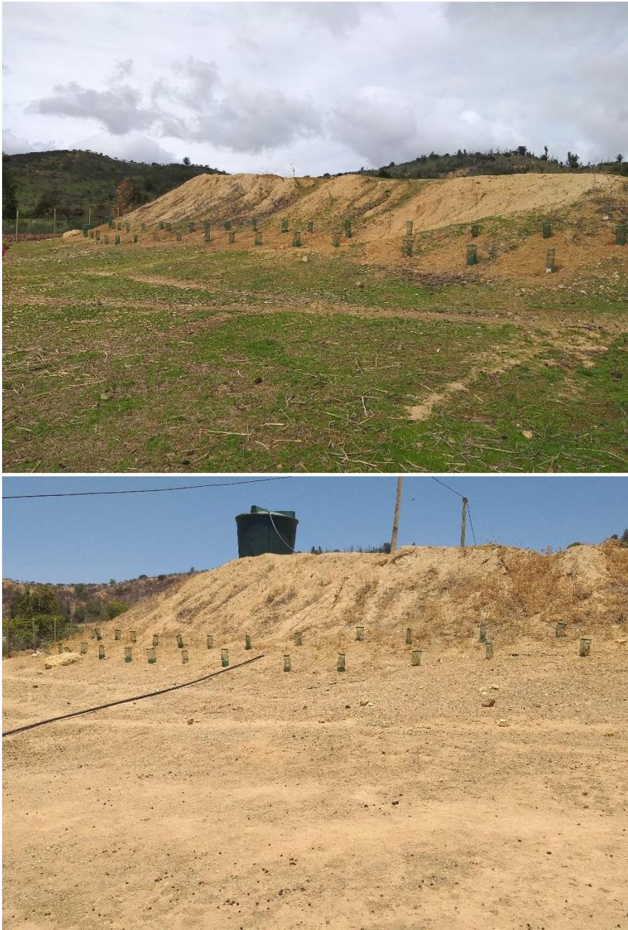
**Figuras 77-78.** Plantación de quillay y romerillo con protectores individuales para control de talud.
