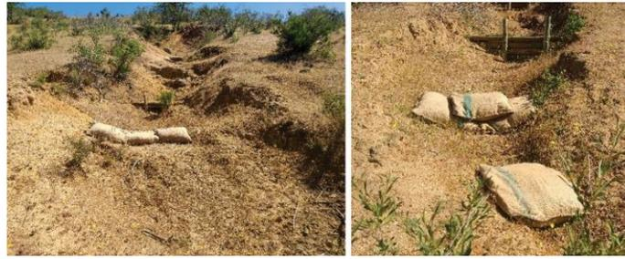
**Figura 6.** Uso de barreras de sacos con semillas de especies herbáceas y/o arbustivas en el interior de la cárcava para disminuir velocidad del agua lluvia y comenzar a introducir cobertura vegetal.
