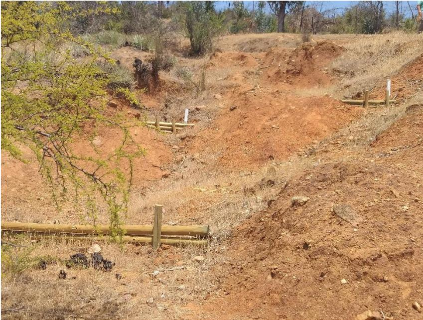
**Figura 95.** Intervención con empalizadas la cárcava 3.
