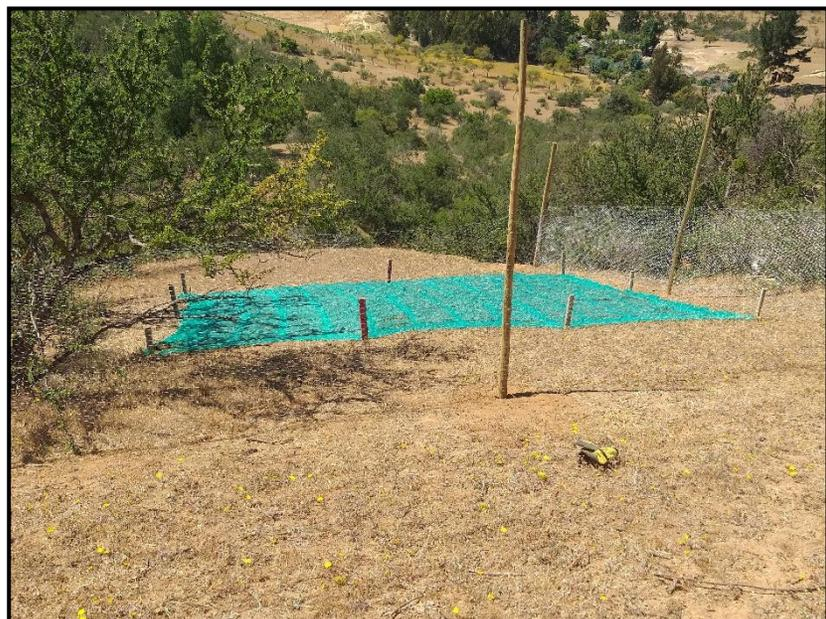
**Figuras 43 y 44.** Uso de mallas talud para reducir escurrimiento superficial y añadir cobertura vegetal; con cercado correspondiente para protección de plantas de Chagual.
