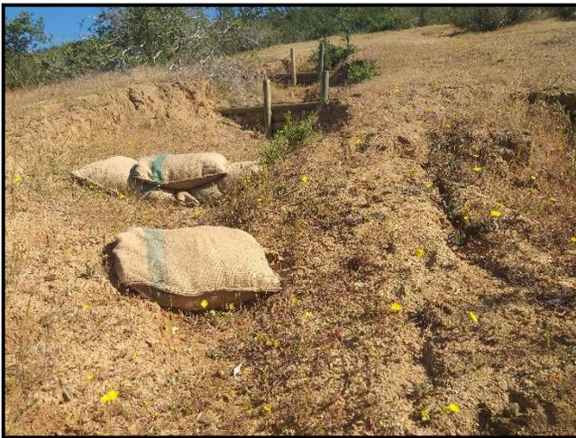
**Figuras 45 a 47.** Zonas con incorporación de barreras utilizando sacos.
