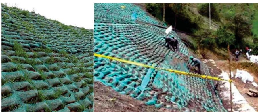
**Figura 5.** Malla talud para el control de la erosión, con siembra para añadir cobertura vegetal.
