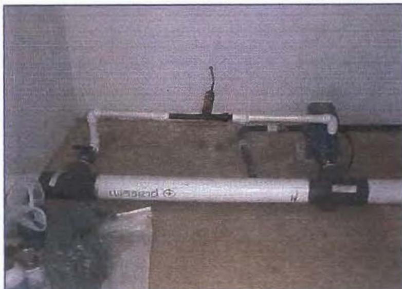
Figura 3. Instalación de un inyector Venturi formando un *by-pass*.
