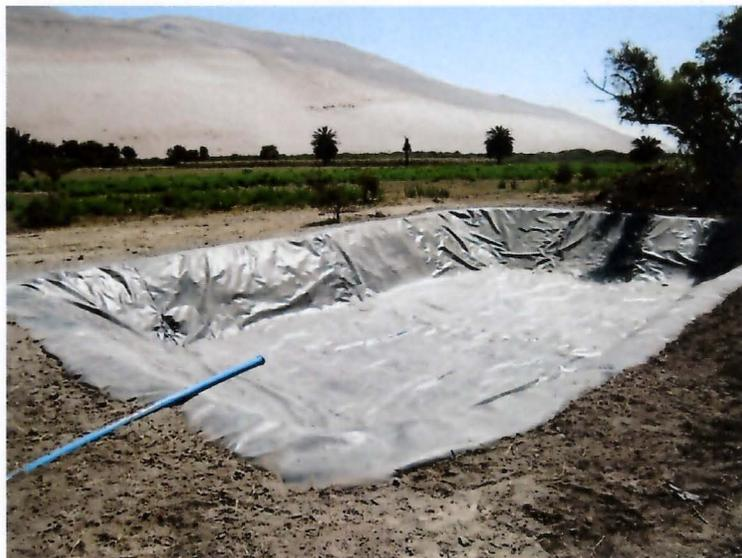
Foto N°7.- Habilitación de estanque acumulador para riego tecnificado.
