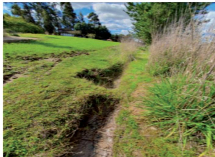
Foto 1. Saltos en el canal de desagüe para reducir velocidad y fuerza del agua.
