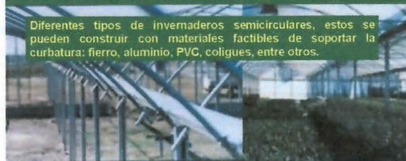
Diferentes tipos de invernaderos semicirculares, estos se pueden construir con materiales factibles de soportar la curvatura: fierro, aluminio, PVC, coligues, entre otros.
