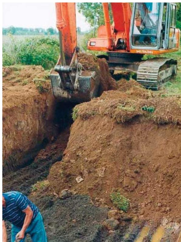
Foto 7. Preparación de un dren tipo zanja.
