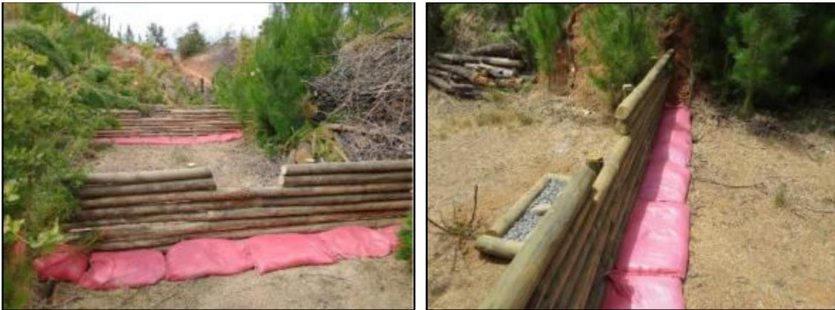
**Diques con disipador de rocas y sacos para disipar la energía de la escorrentía. 2020.**
