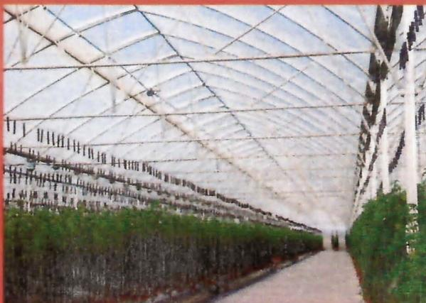
A mayor altura, mayor es la masa de aire interior, encargada de amortiguar los cambios de temperatura y humedad relativa.
