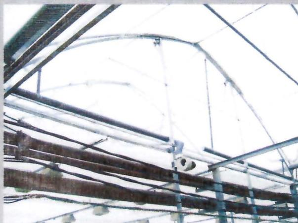
En zonas muy frías es necesario reforzar el aislamiento con un doble recubrimiento plástico hinchable, cuya cámara de aire actúa como una barrera muy efectiva contra la fuga de calor.
