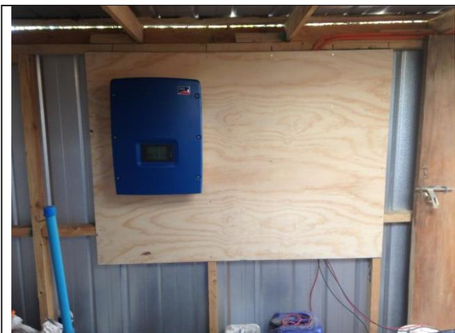
Inversor Trifásico SMA 5k montado.
