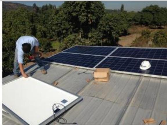
Montaje de paneles fotovoltaicos
