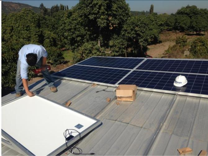
Montaje de paneles fotovoltaicos
