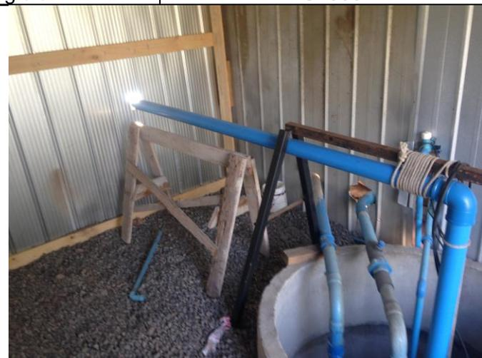
Bomba instalada con PVC 75mm
