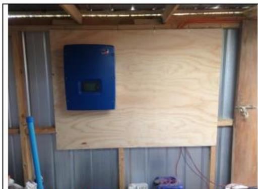
Inversor Trifásico SMA 5k montado.
