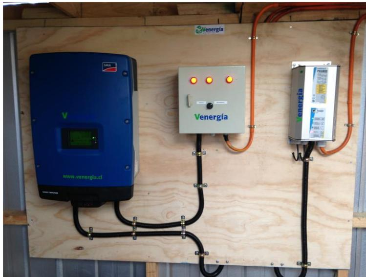
**Puesta en marcha inversor:** al encender bombas de riego, después de 1 minuto inversor sincroniza con la red y comienza inyectando 1257W
