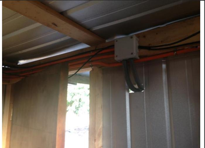
Llegada de cableado fotovoltaico a caseta.
