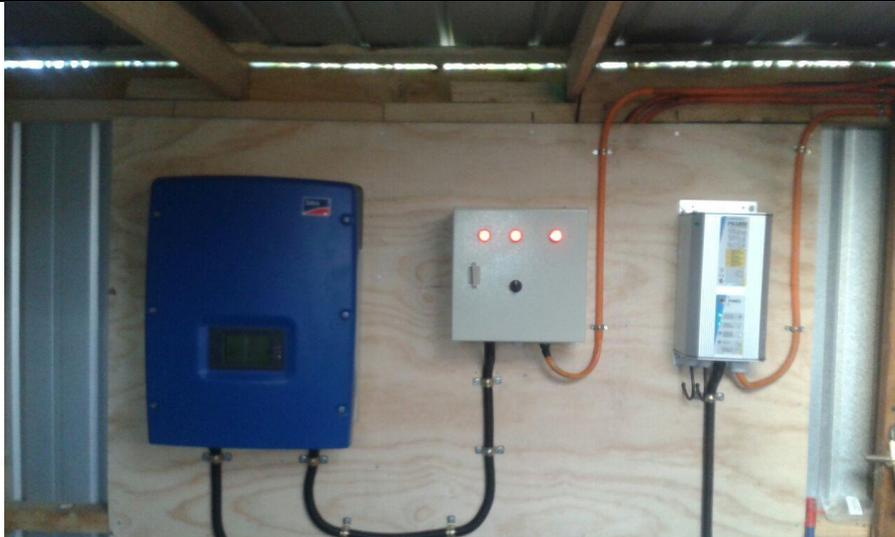
Tablero que no permite inyección a la red en conjunto inversor y control de bomba.
