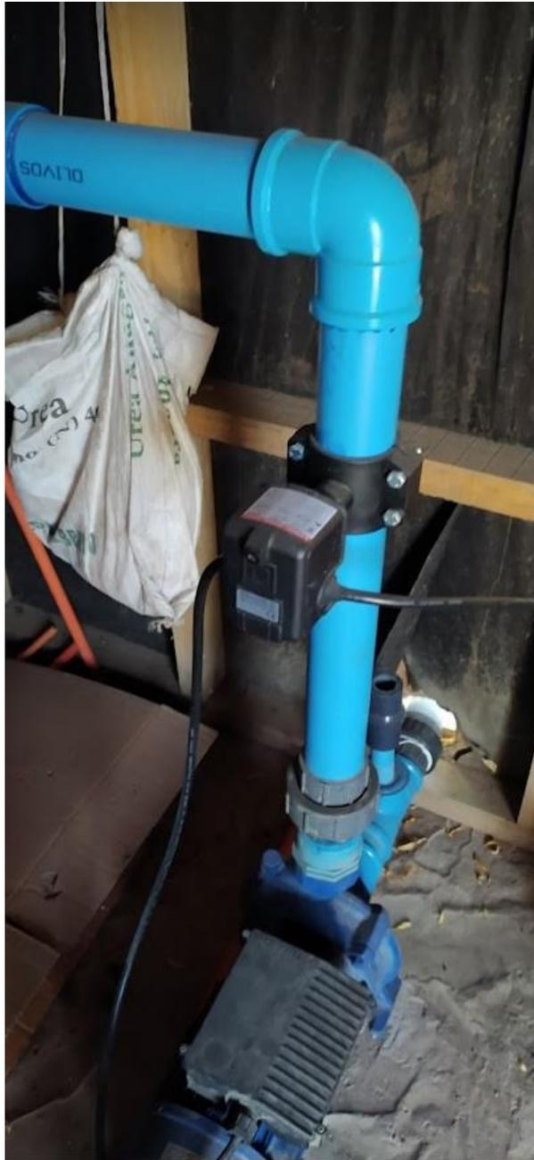
Figura 40. Estado actual del presostato.
