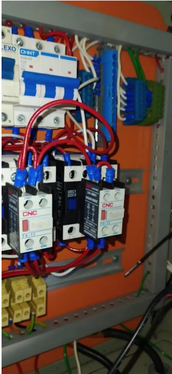
Figura 42. Recambio de regletas de línea de neutro y bandejas eléctricas.
