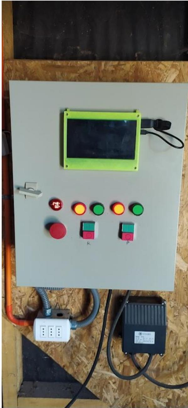
Figura 41. Gabinete de control con interfaz de usuario y visualizador voltaje/corriente.
