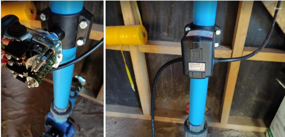
Figura 29. Instalación de presostato en caseta de control.
