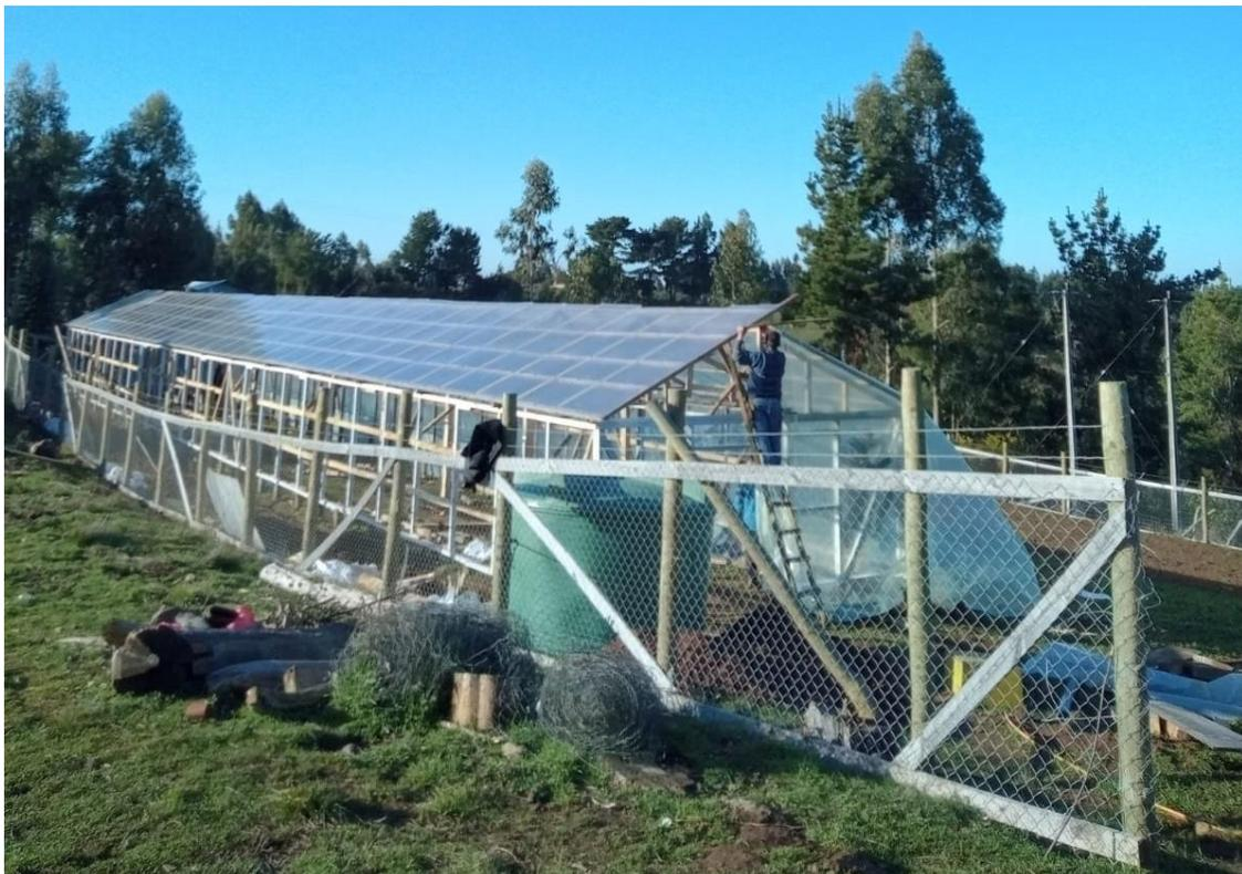
Foto 3. Instalación de planchas de policarbonato para techo.
