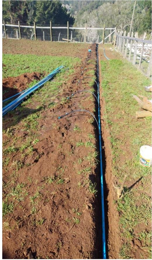
**Foto 4 y 5. Instalacion de sistema de riego en invernadero y al aire libre.**
