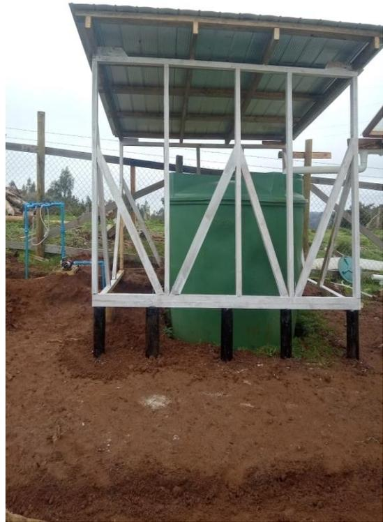
**Foto 3. Proteccion de estanque de almacenaje.**
